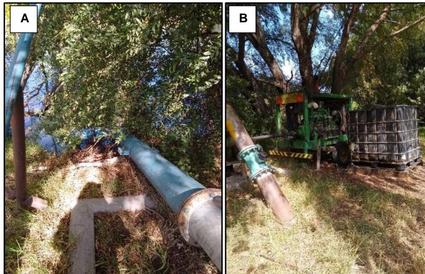
**Figura 16.** A: Toma de agua de la bomba que abastece a los pivots. B: Bomba John Deere junto al tanque de gasoil.
