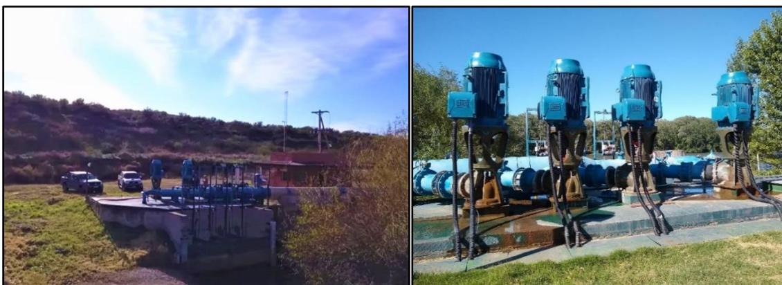
Figura N°11: Estación de bombeo principal en la zona de valle, con cuatro bombas de  $1000 \text{ m}^3 \text{ h}^{-1}$  de caudal.
