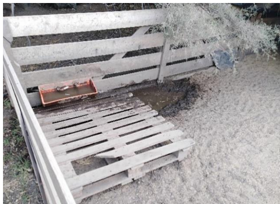
Figura 23: Chupetes instalados para la provisión de agua. Foto propia.
