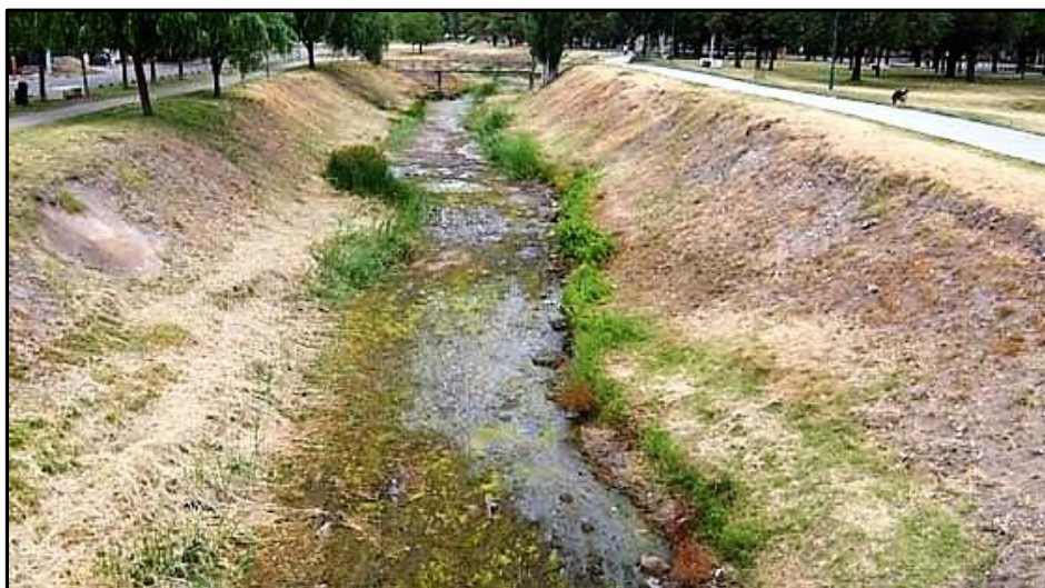
Figura 37. Estado del arroyo Napostá Grande en un sector de su tramo inferior
