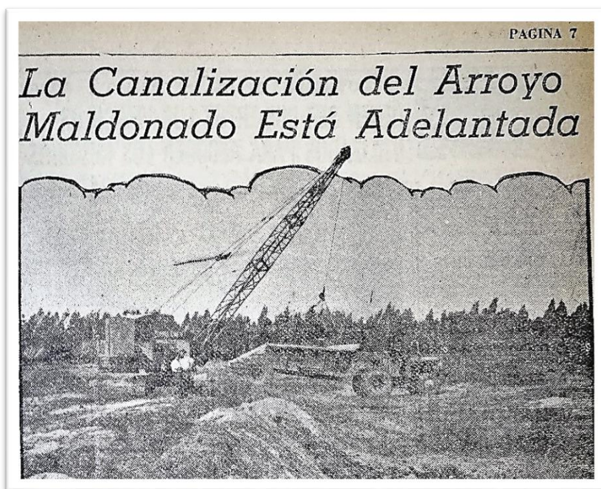
Figura 27. Noticia alusiva a las tareas de canalización del arroyo Maldonado
