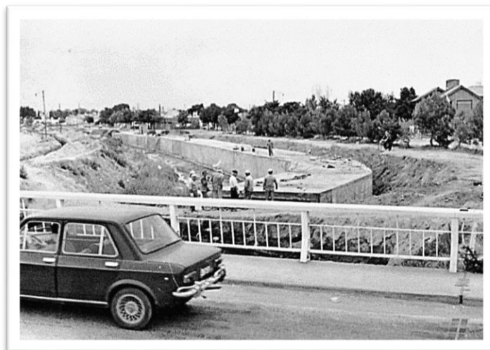
Figura 32. Segunda etapa de la realización del entubado del arroyo (1981)
