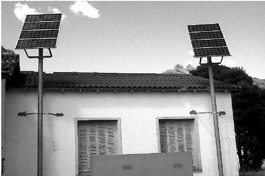
Figura n.º 4. Instalación fotovoltaica en la Escuela Primaria n.º 30 “Paraje San Cala” de Juan N. Fernández, Necochea, Buenos Aires
