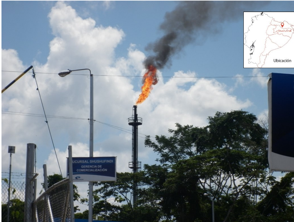
Foto 4. Refinería de petróleo en Shushufindi Fuente: Elaboración propia, Martha Villagómez, 2012
