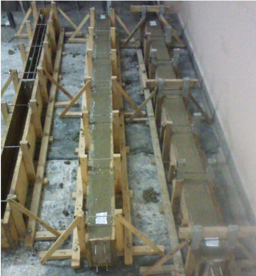
Encofrados de vigas de ensayo en proceso de llenado
