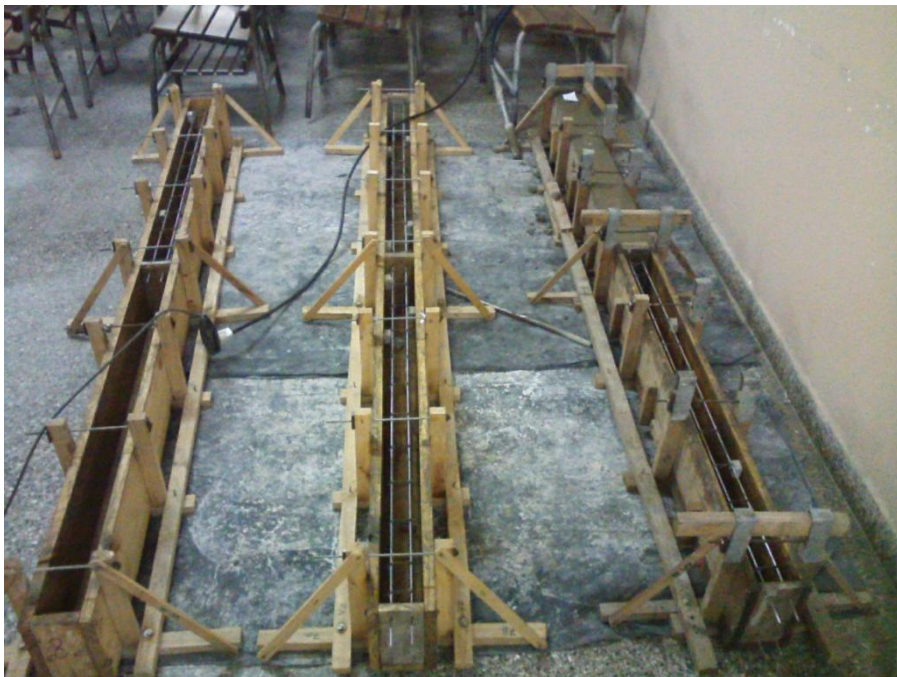
Encofrados de vigas de ensayo
