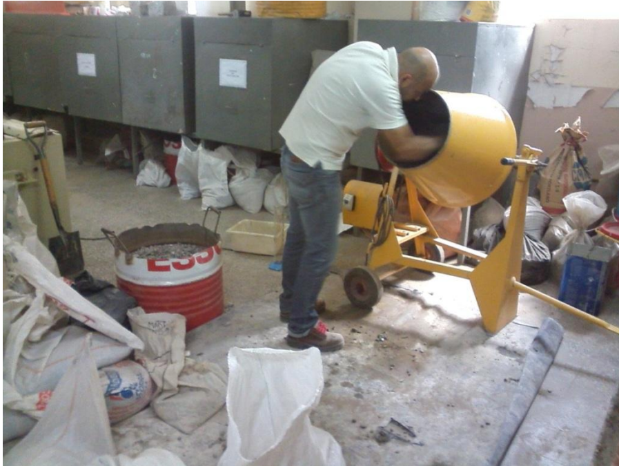
Incorporación de materiales en la hormigonera - hormigonado
