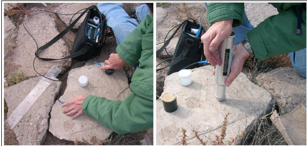
Figura 4.9: Ensayos no destructivos sobre elementos de hormigón
