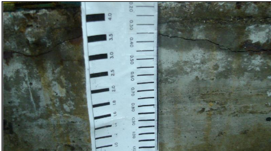
Figura 6.2 Medición del ancho de fisuras
