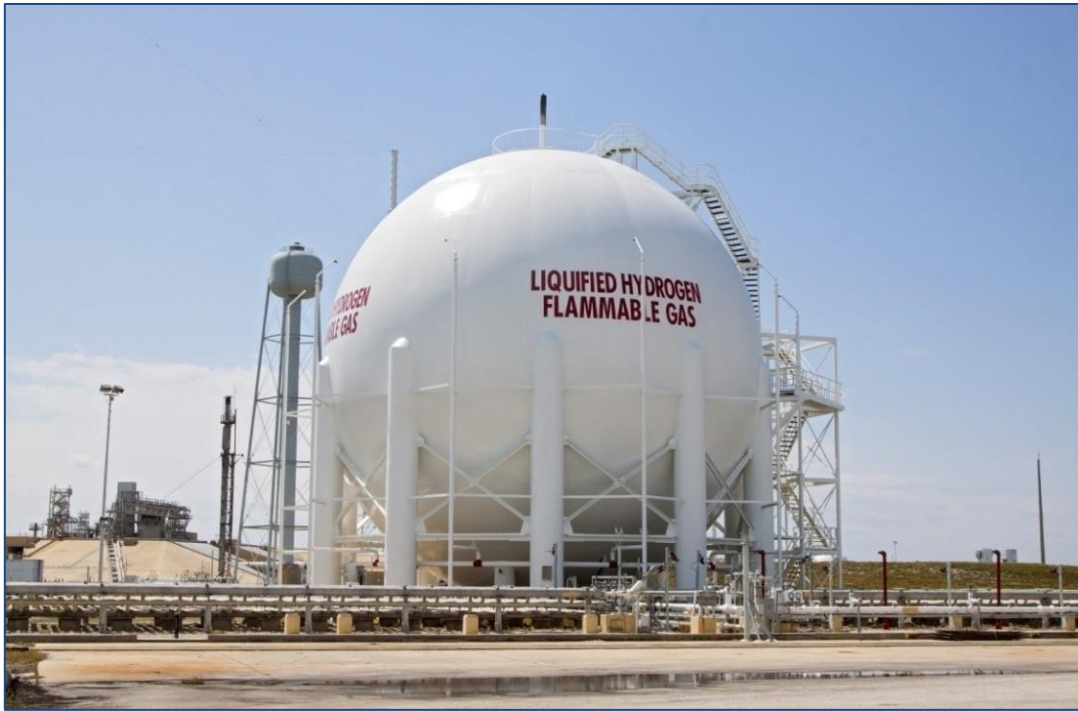
Fig. 2.6- Tanque esférico que contiene hidrógeno líquido, en el predio del Centro Espacial Kennedy 15 .
