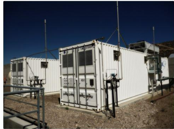
Moto-Generador de 1,4 MW
