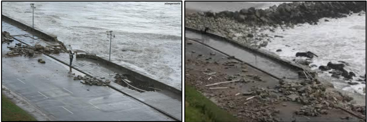
Figura 5.5 Destrucción del Paseo Dávila durante la sudestada de 2009 Fuente: http://www.lacapitalmdp.com/noticias/La-Ciudad/2009/07/29/116755.htm
