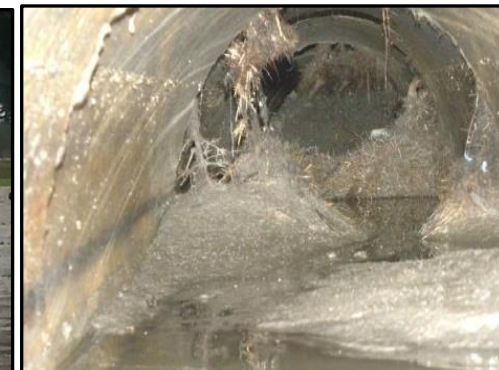
Figura 6.17. Pluviales tapados. Fuente: OSSE, 2015
