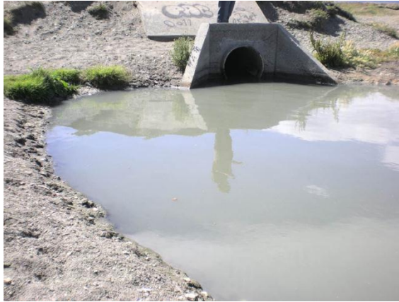
Figura 5. Fotografía de la salida de rebalse hacia el canal de una Estación Elevadora sobre Bahía Golondrina.
