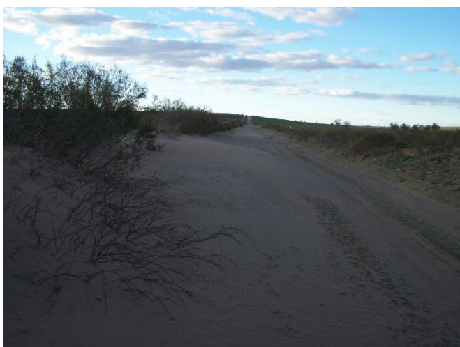
Camino y banquetas tapados signos de Erosión Eólica (Municipio de Villarino)
