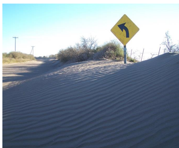
Banquinas y señalización de tránsito con acumulación de suelos signos de Erosión Eólica (Municipio de Patagones)
