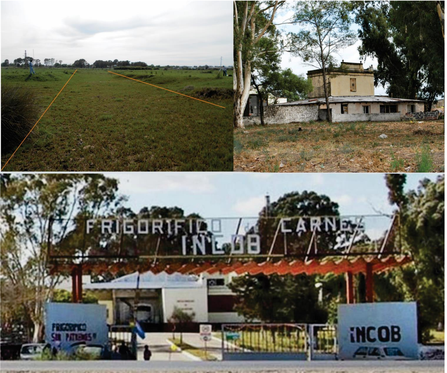
Figura 2: Estado actual de las estructuras. A la izquierda se observa un tramo de la "Zanja de Rosas". A la derecha, la estancia "La Catalina". La imagen inferior muestra el frente de las instalaciones de la cooperativa.
