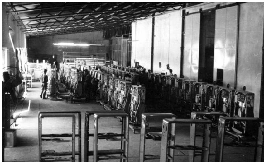
Montaje de surtidores de nafta en Metalúrgica Bahía Blanca. AMUNS
