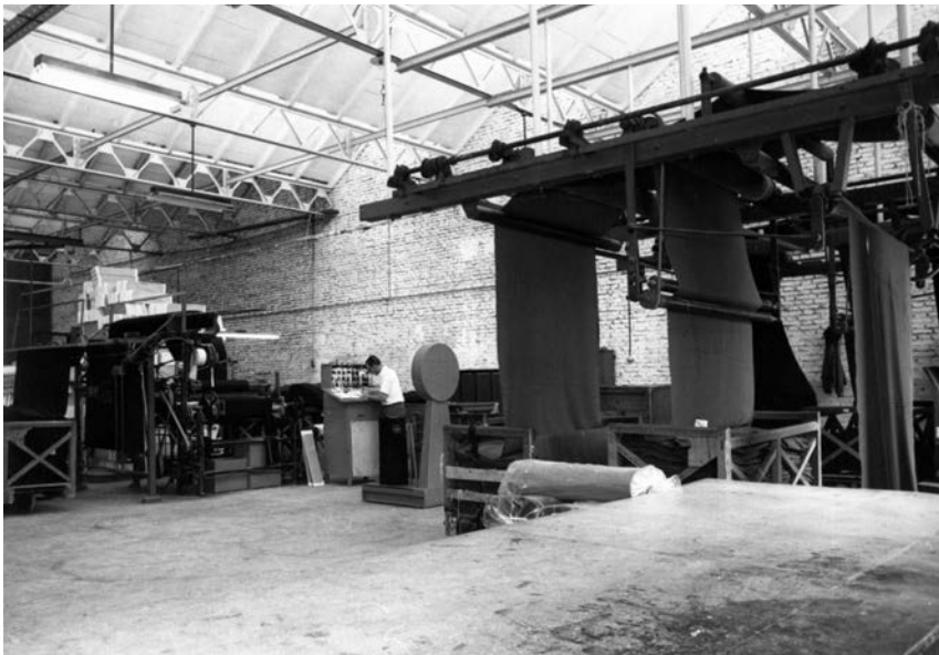
Interior de la Lanera San Blas. Archivo de la empresa
