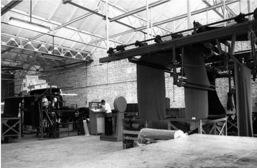
Interior de la Lanera San Blas. Archivo de la empresa
