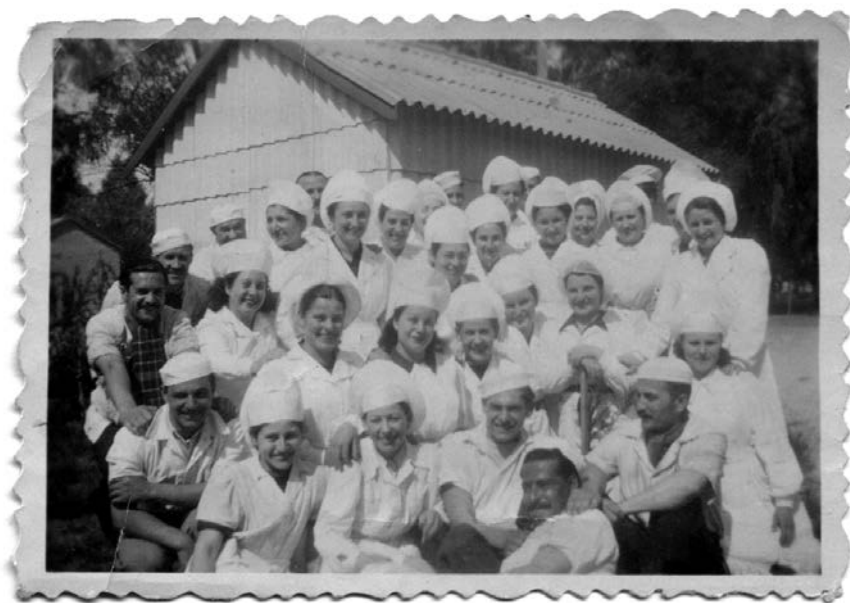
Obreros de CAP en el sector de acceso a la planta. AMUNS
