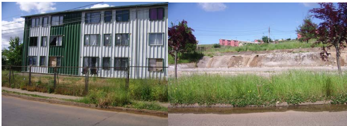
Figura N° 47.- Temuco: Viviendas sociales abandonadas
