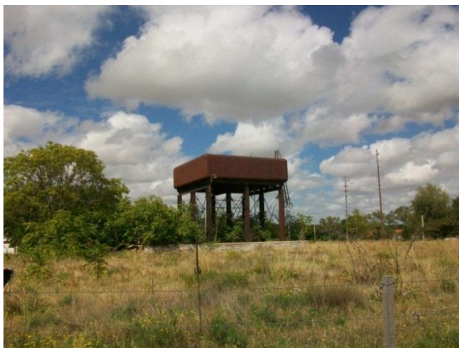
Figura 13 Tanque de combustible
