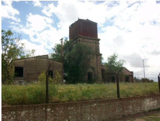
Figura 12 Tanque suplido de agua
