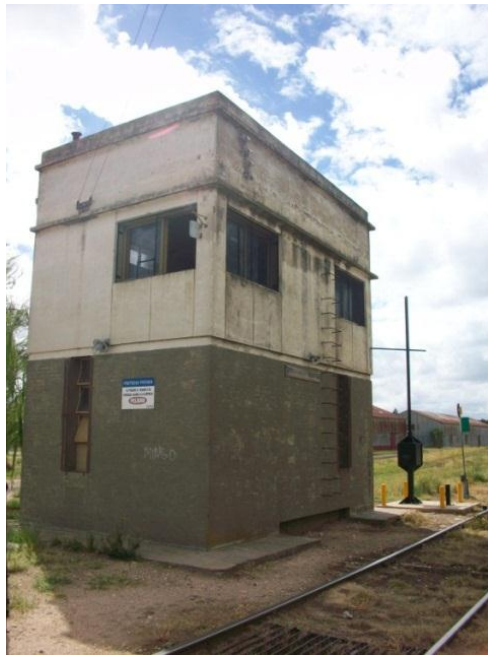
Figura 4 Cabina de señales
