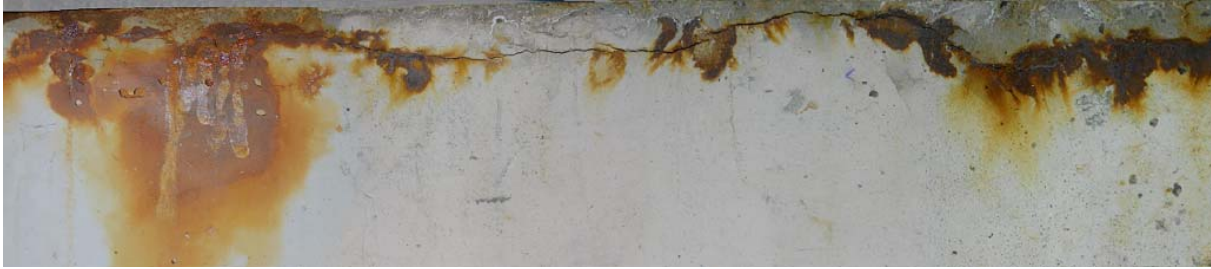
Figura 8.47: Fisura longitudinal lateral de la viga HAN.
