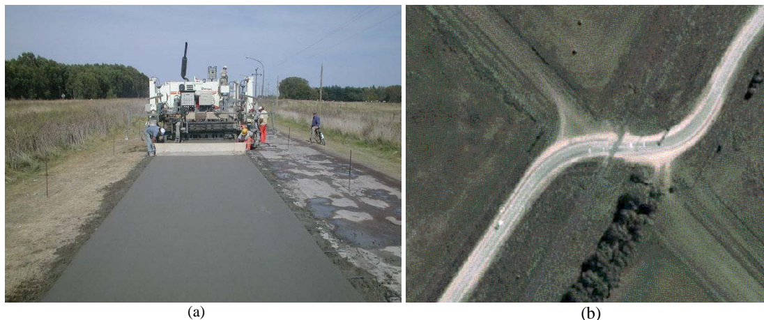
Figura 2.13: Pavimento en Olavarría: construcción (a), y vista satelital (b) ( www.maps.google.com ).
