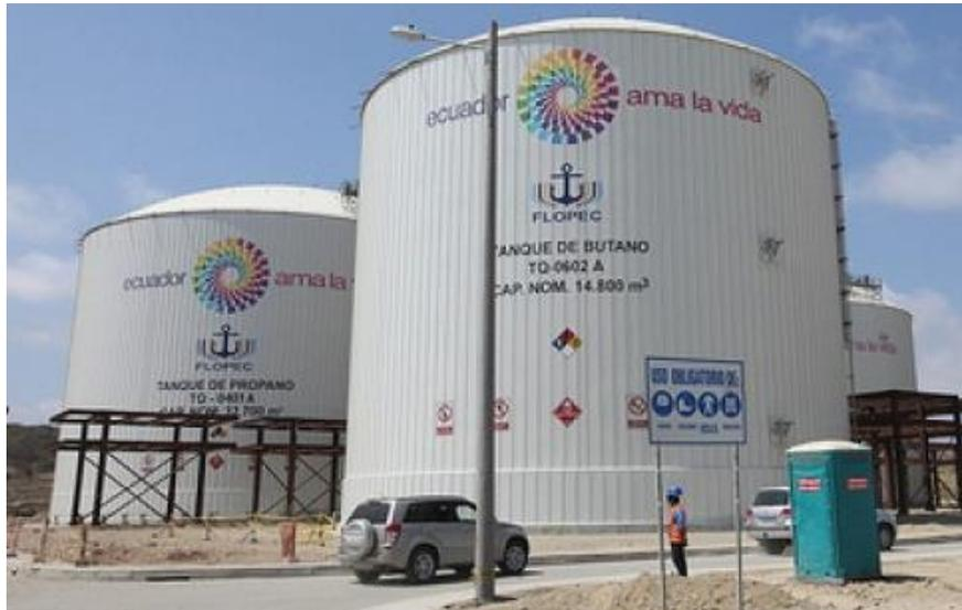
**Figura 2.5 Tanque de almacenamiento de butano**
