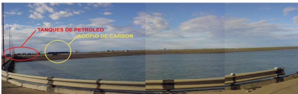
Figura 5: Instalaciones de acopio de petróleo y carbón. Se encuentran ubicadas sobre en el sector inmediato al ingreso al muelle.
