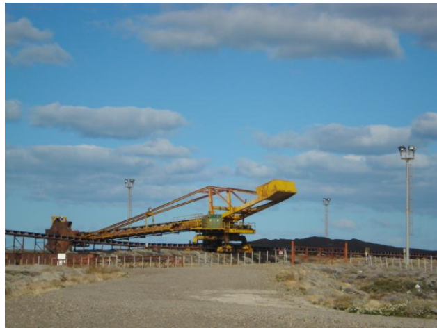
Figura 4: Predio Portuario Acopio, manejo y estiba de carbón en el predio inmediato al muelle.
