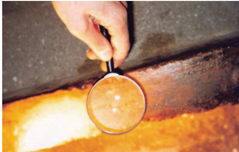
Figura 10.3: Vista de una fisura en la cara superior de la viga
