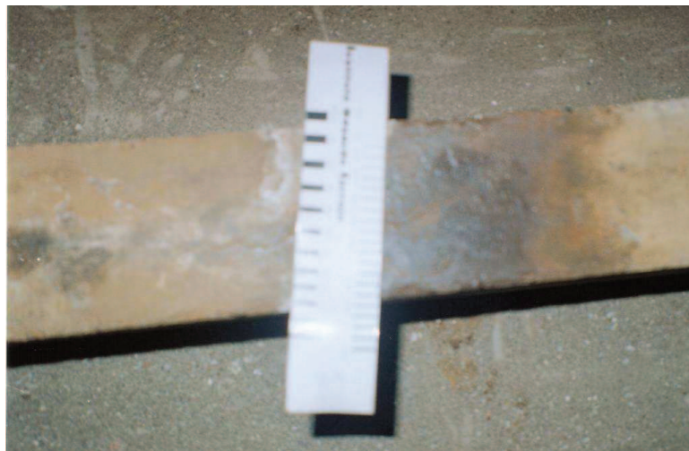
Figura 10. 2: Medición de las Fisuras
