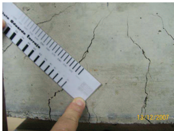
Figura 6.31: Medición de Fisuras
