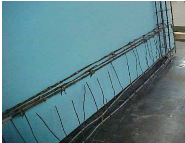
Figura 10.6: Deterioro de la armadura longitudinal y transversal
