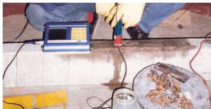
Figura 10.4: Determinación de los Potenciales de Corrosión
