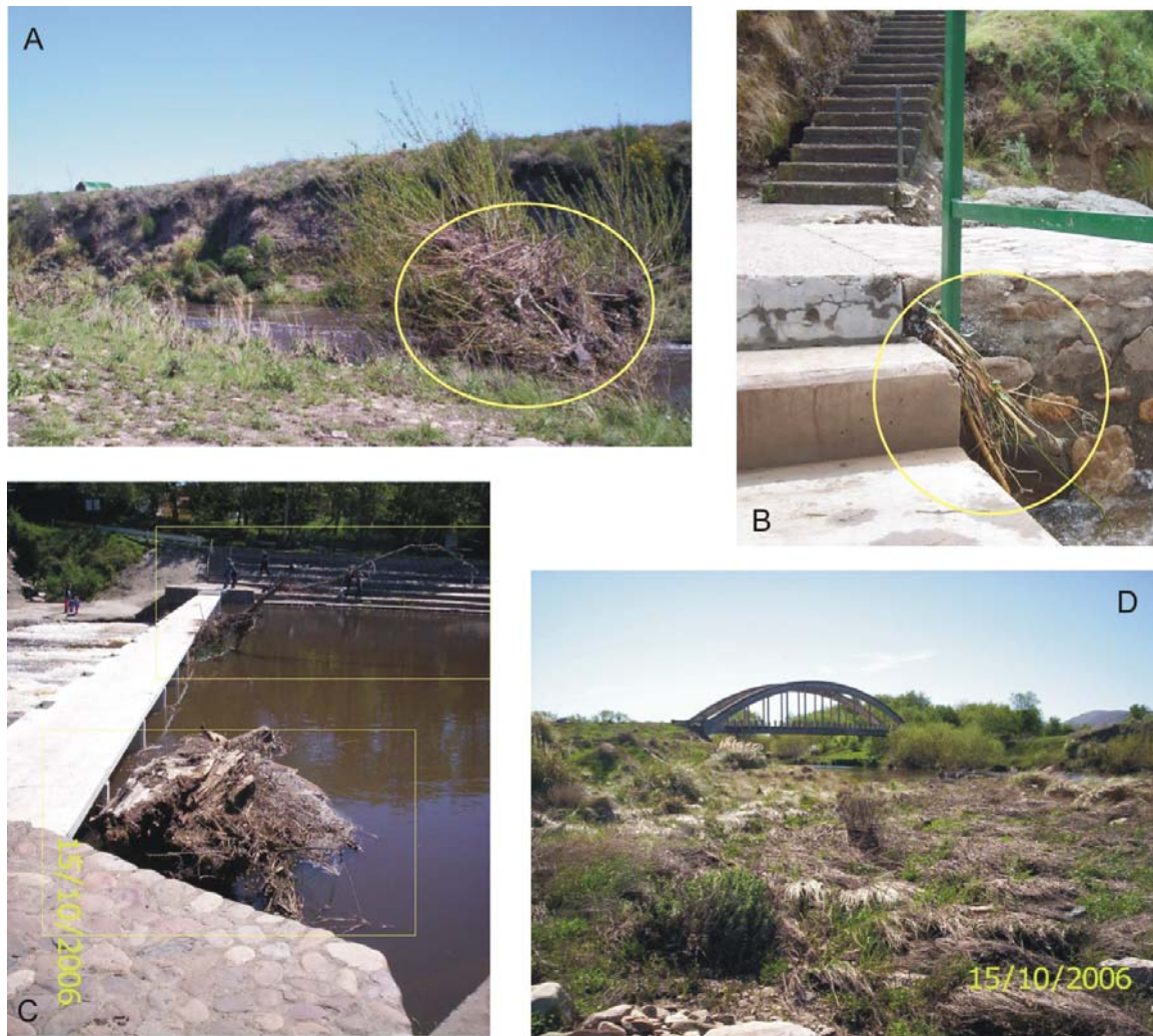
Figura 9.13. Presencia de restos indicativos de la altura del agua en diferentes crecidas del río. En la figura A, B y C se observan restos de troncos y objetos arrastrados por el flujo de agua. En la figura D se observa el achatamiento del pastizal que se encuentra dentro de la llanura inundable producto del paso del agua en el tramo de estudio. Fotografías tomadas por la autora.
