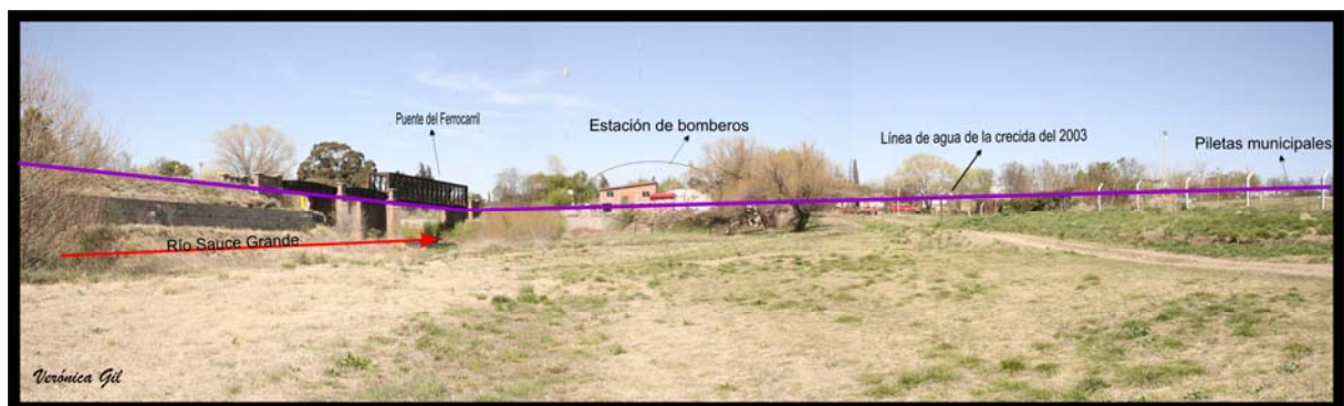
Figura 10.7. Línea de altura de agua de la crecida de 2003 en el sector de piletas municipales. Al fondo de la fotografía se observa la estación de bomberos, a la derecha el alambrado de las piletas municipales y a la izquierda el puente de ferrocarril construido por los ingleses. El río Sauce Grande escurre en sentido de la flecha roja en este sector.
