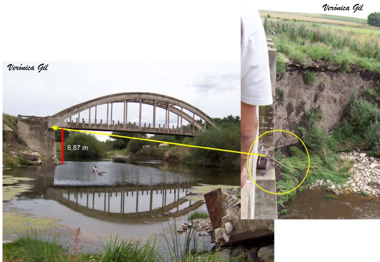
Figura 10.15. Altura del agua en la crecida del 2003 en el puente Peralta. En el círculo amarillo se observan restos de vegetación dejados por la misma crecida a partir de los cuales se estableció la altura aproximada de la línea de agua.
