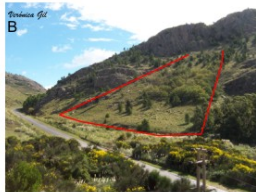
Perfil 16 entre los 600 y 500 m. Depósitos antiguo producido por un deslizamiento vegetado. Movimiento de creep actual en la parte baja.
