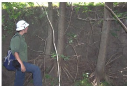
Exposición de las raíces por zapamiento de talud
