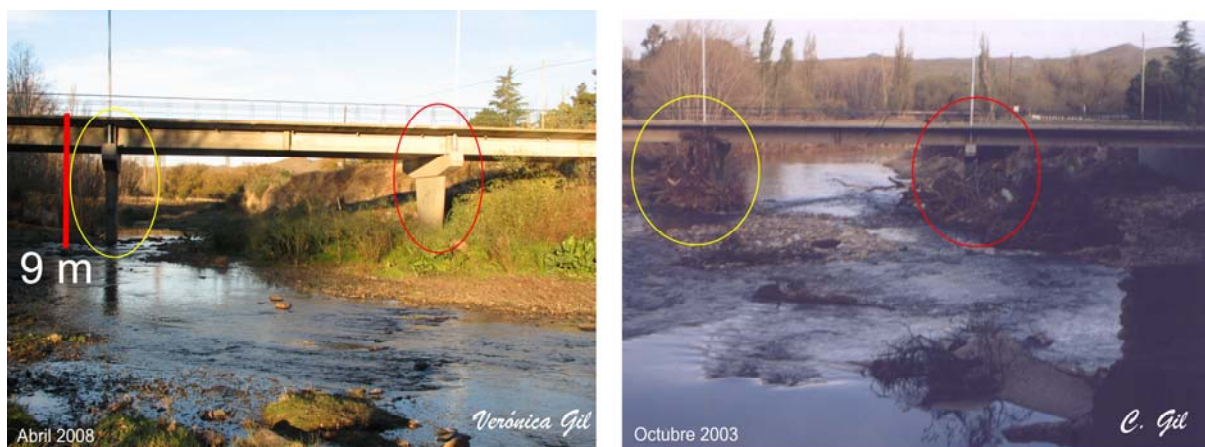
Figura 10.13. Puente entre villa La Arcadia y Sierra de la Ventana. En la fotografía de octubre se observa la resaca en las pilas que sostienen el puente luego de la crecida del 7 de octubre. El agua sobrepasó el puente 1,5 m.
