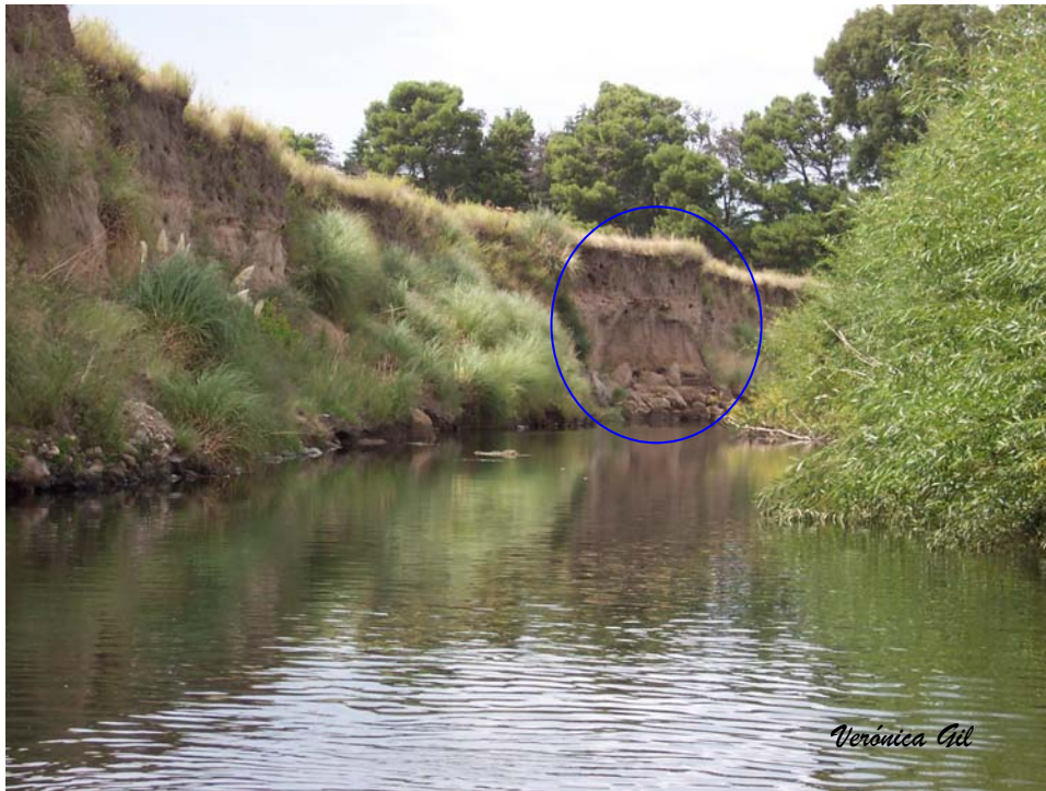
Figura 9.16. Colapso de material de la barranca. Sector sin vegetación, margen izquierda.
