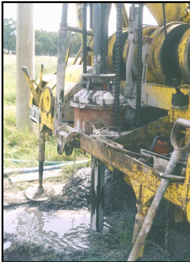
Foto 2.2.5. Detalle de perforación de un pozo profundo
