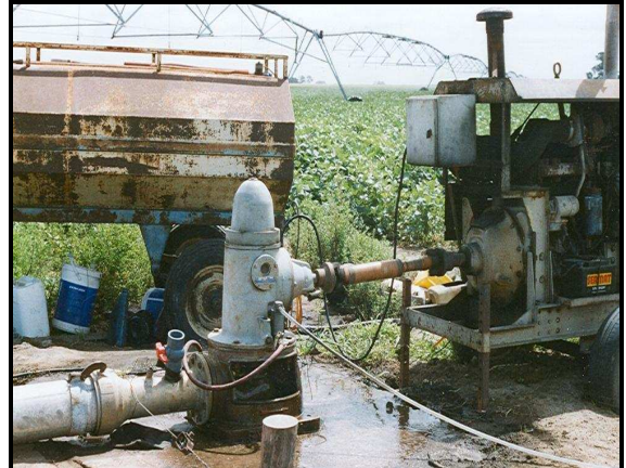
Bomba, perforación y tuberías.
