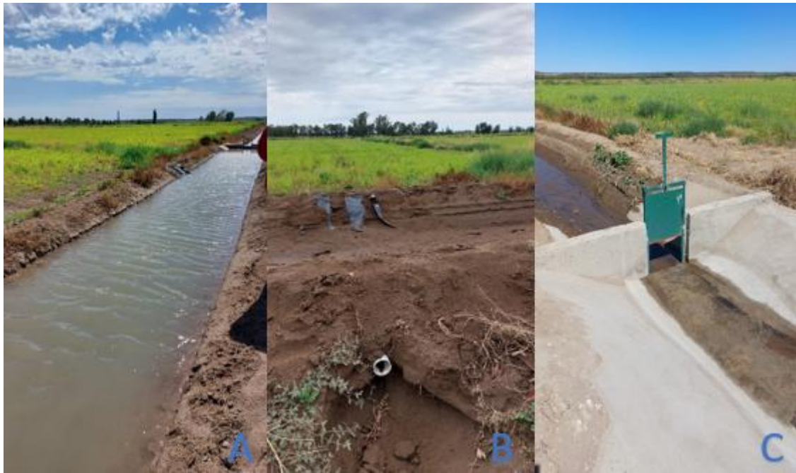
Figura 25. Componentes del sistema de riego gravitacional: canal(A), tubería de conducción (B) y compuerta de regulación (C).
