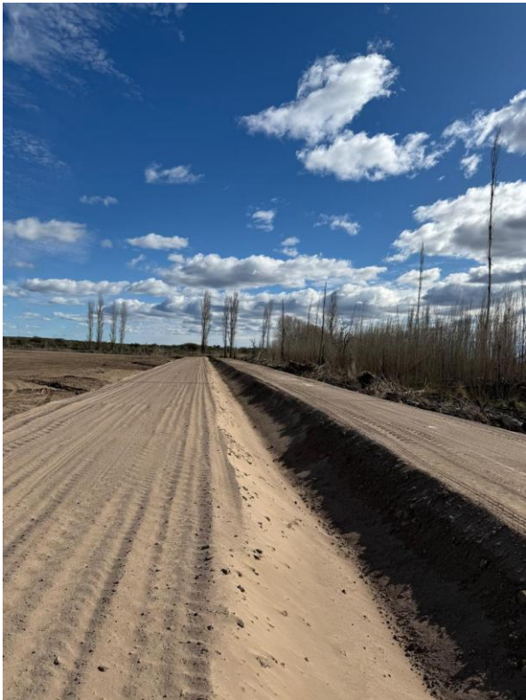
Figura 22. Mesada levantada para la posterior apertura del canal de riego.
