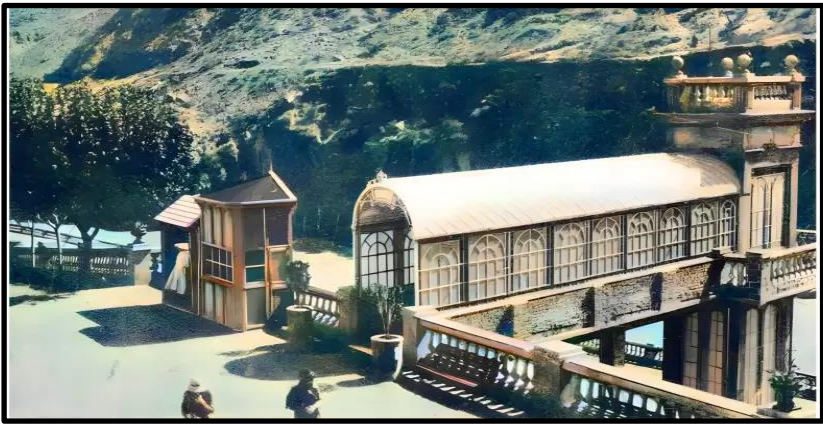
Figura IX Vista del acceso del ascensor de los baños termales de Cacheuta
