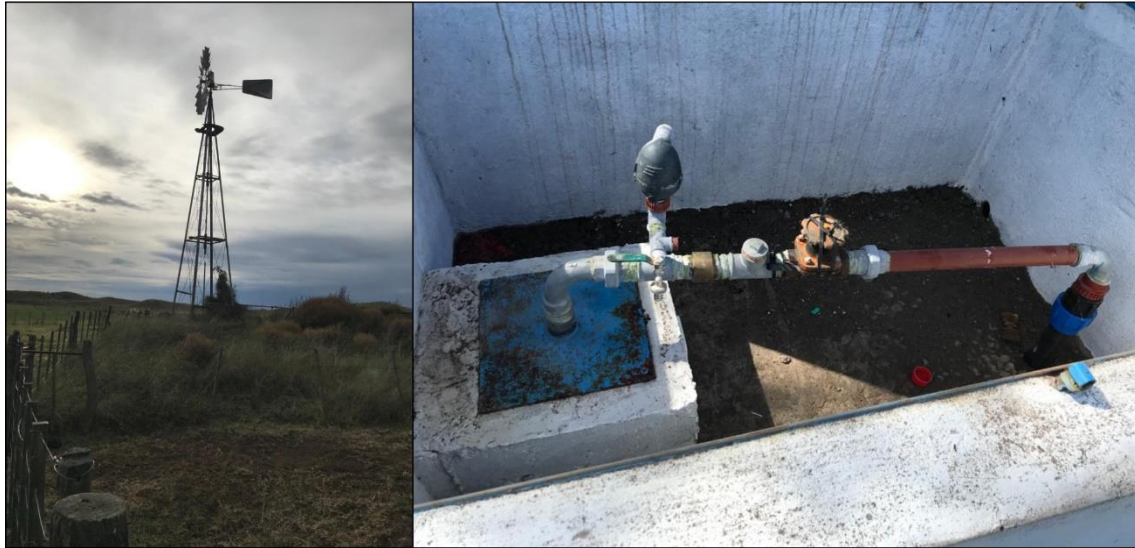
Figura 6.2.1.1. Tipos de captaciones en el área de estudio: molinos (izquierda) y pozos con bombas electrosumergibles (derecha).
