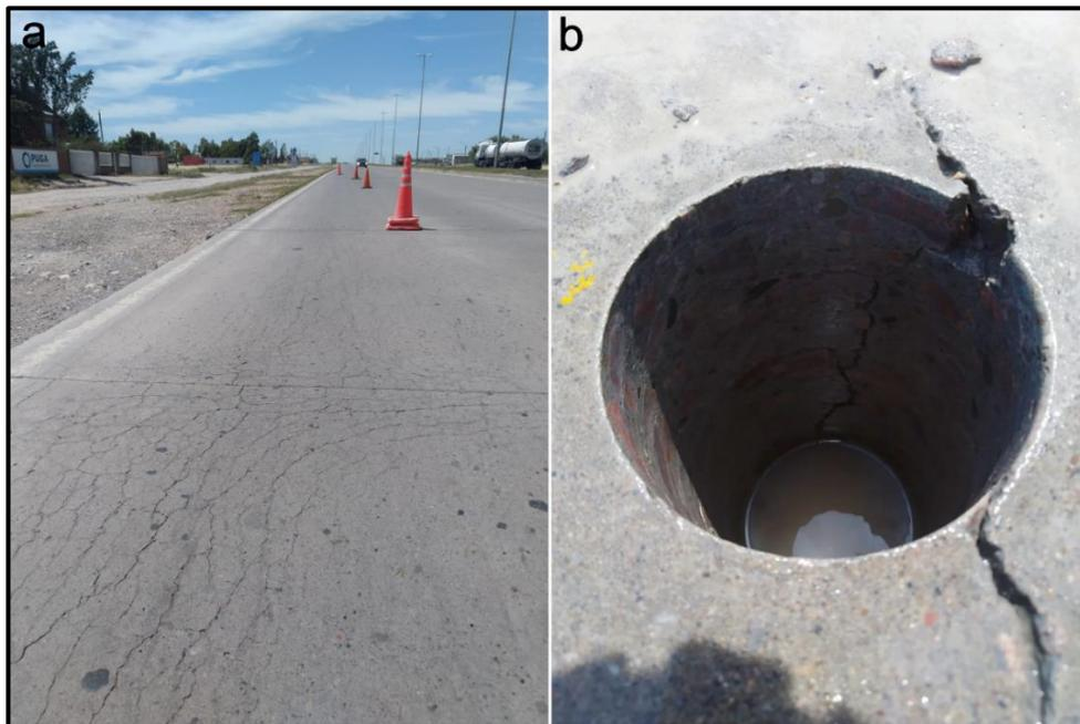
**Figura 6.12** Autovía Juan Pablo II a) superficie del carril descendente; b) hueco originado por la extracción de un testigo (nótese que la fisura atraviesa el espesor del mismo)
