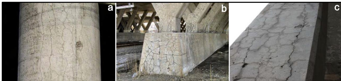
Figura 1.11 Potencialidad de RAS según la exposición a) Baja; b) Moderada; c) Alta. (Tomado de Thomas et al., 2013)
