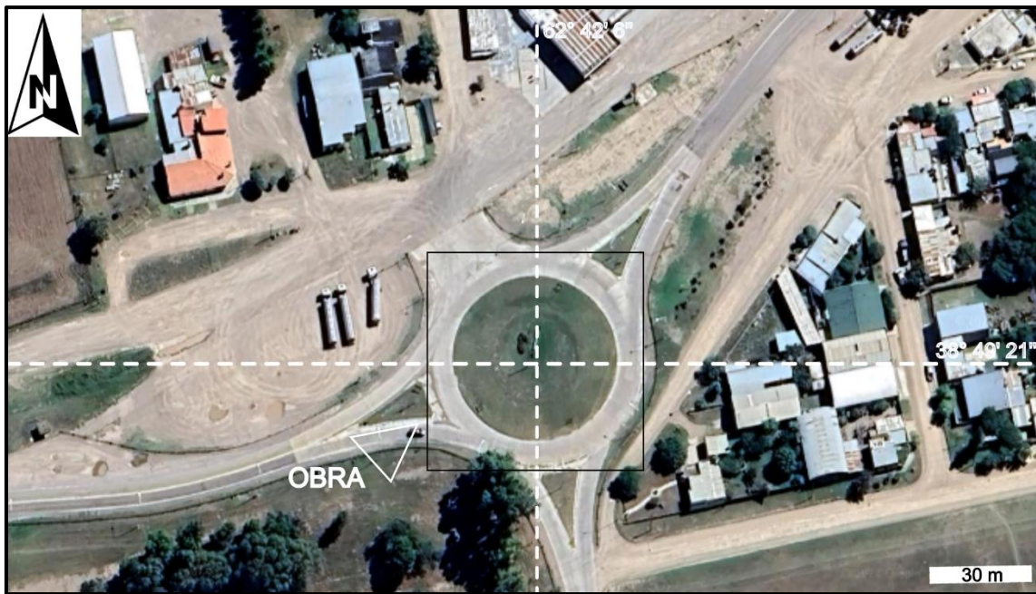
Figura 6.30 Ubicación de la rotonda de acceso a la localidad de Médanos (Ruta Nacional N°22 – Km 733). Tomado de Google Earth®
