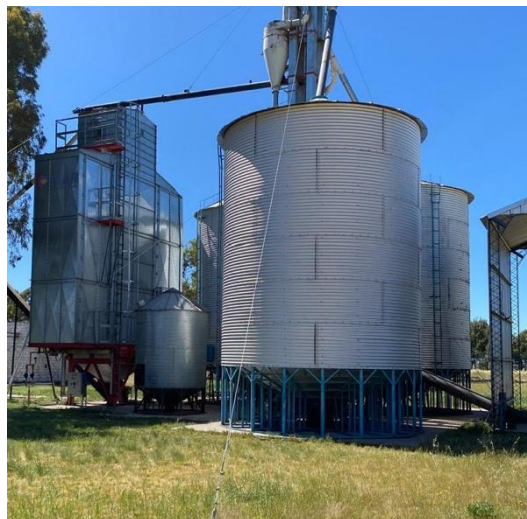
Figura 31: silos junto a la secadora.
