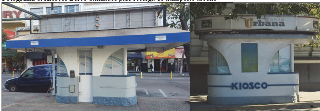
Fotografía 6. Kioscos Barco utilizados para recarga de transporte urbano
