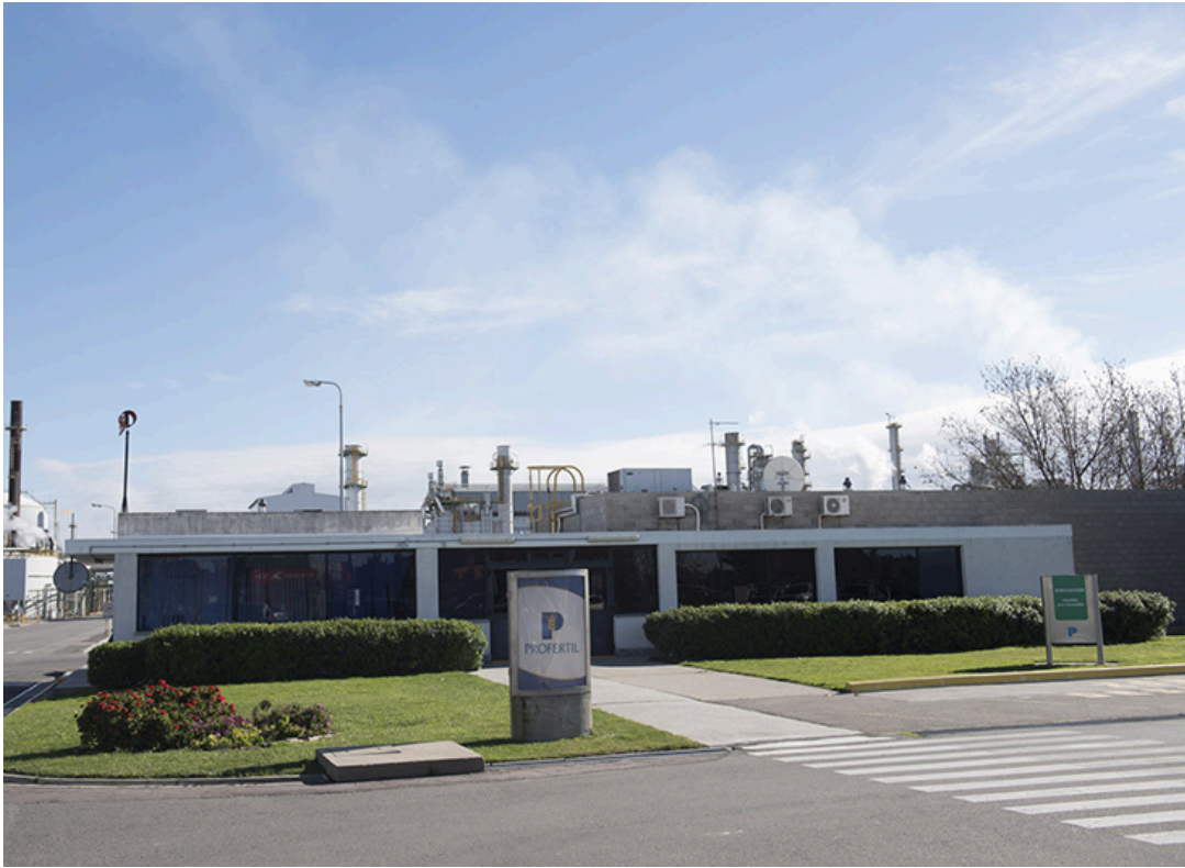
Foto 1. Sector de ingreso a la planta de Profertil en Ing. White.
