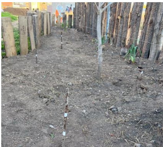
Foto 4: Uso de varillas para nivelación.
