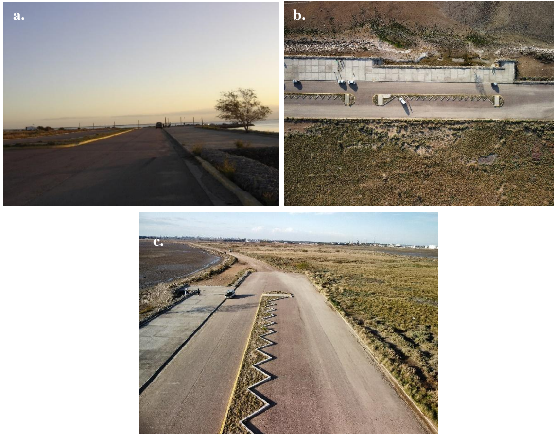
a) Vista del estacionamiento del Paseo b) Vista cenital del estacionamiento c) Vista longitudinal.
