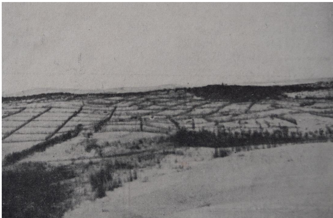
Figura 3.3. Sector correspondiente a dunas activas donde se observa la disposición de plántulas de espartillo ( Spartina ciliata ), a modo de enquinchados vivos, siguiendo un diseño en grillas. Junio de 1944. Fuente: Museo Histórico y Archivo Municipal de Villa Gesell.
