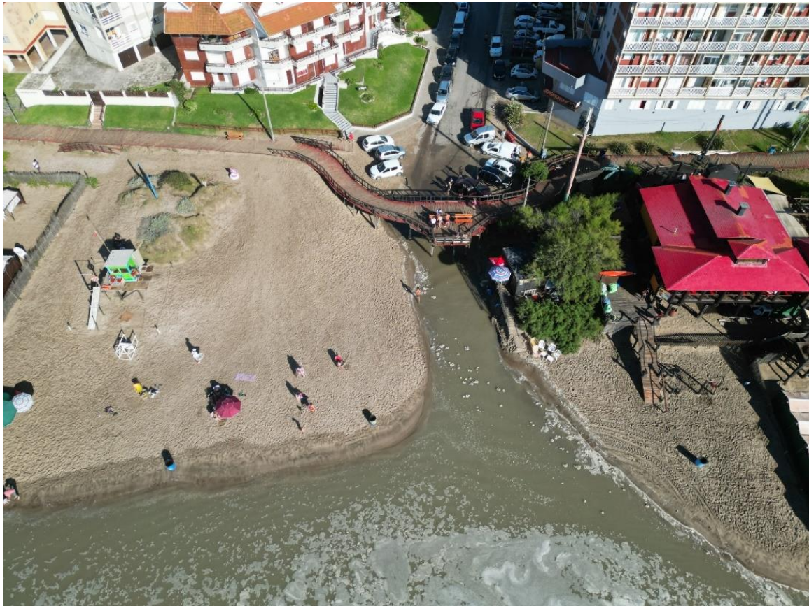
Figura 6.19. Desagüe pluvial no entubado (con salida directa) perteneciente al Paseo 104 (37°15'27.72"S, 56°57'54.32"O). Febrero de 2024.
