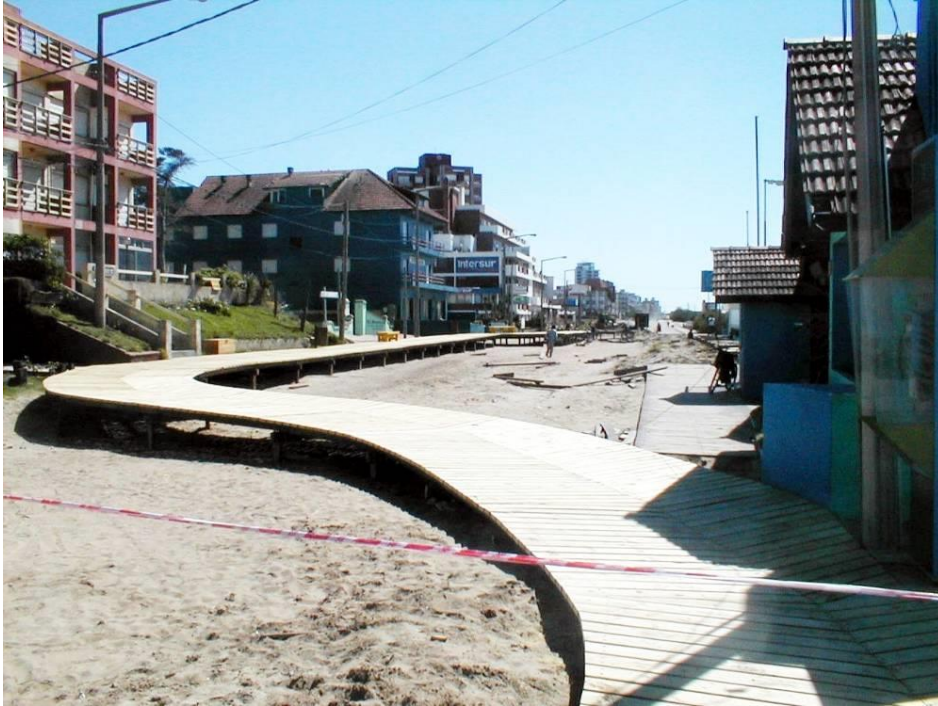
Figura 6.24. Construcción del actual paseo costanero, en el año 2006. Fuente: imagen de archivo del Grupo de Geología de Costas del Instituto de Geología de Costas y del Cuaternario.
