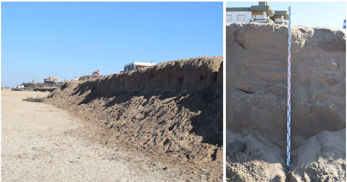
Figura 6.23. Escarpa erosiva de más de 2,6 m, observada a la altura del Paseo 118 y playa (37°16'19.86"S, 56°58'35.75"O), durante relevamientos de campo realizados en Julio de 2022.
