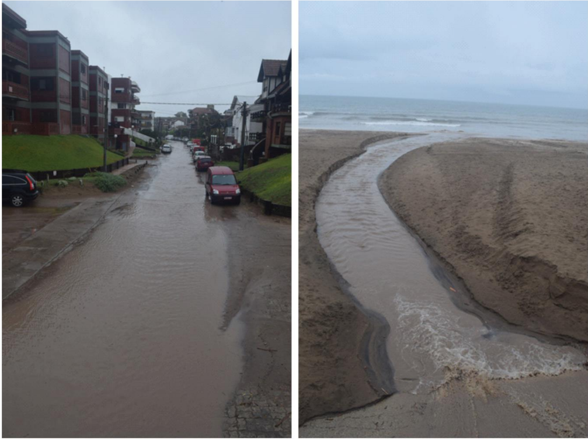
Figura 6.29. Desagüe pluvial sin canalizar a la altura del Paseo 111 (37°15'55.44"S, 56°58'16.05"O), correspondiente a la microcuenca urbana Villa Gesell centro. Fuente: imagen de archivo propio correspondiente al febrero de 2022.
