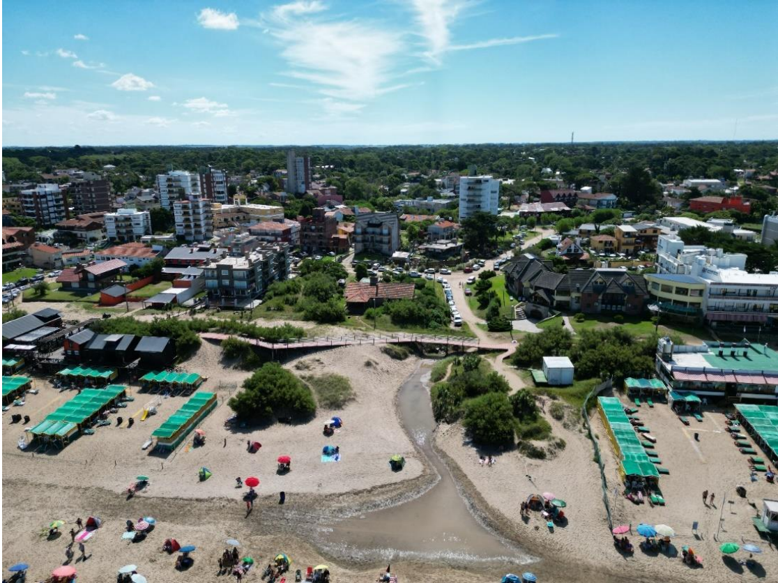
Figura 6.20. Desagüe pluvial entubado, con salida aproximadamente en el pie de dunas, Paseo 118 (37°16'19.86"S, 56°58'35.75"O). Febrero de 2024.
