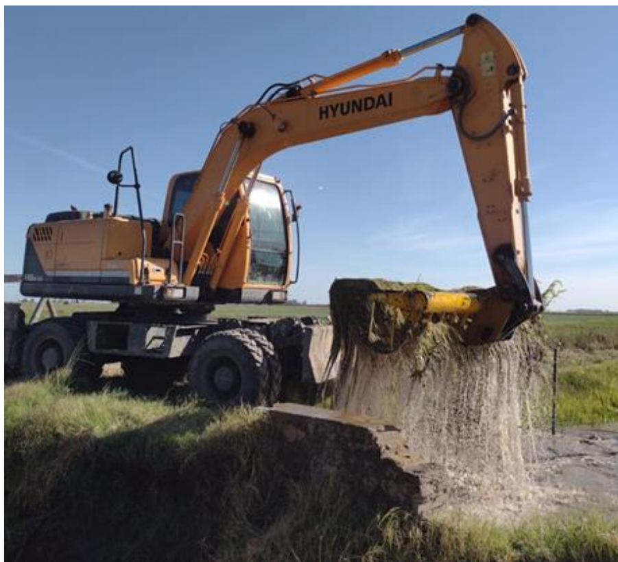
Figura 17. Limpieza de un canal con retroexcavadora equipada con rastrillo.
