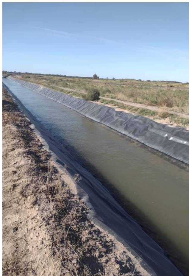
Figura 22. Vista de un canal revestido con geomembrana.
