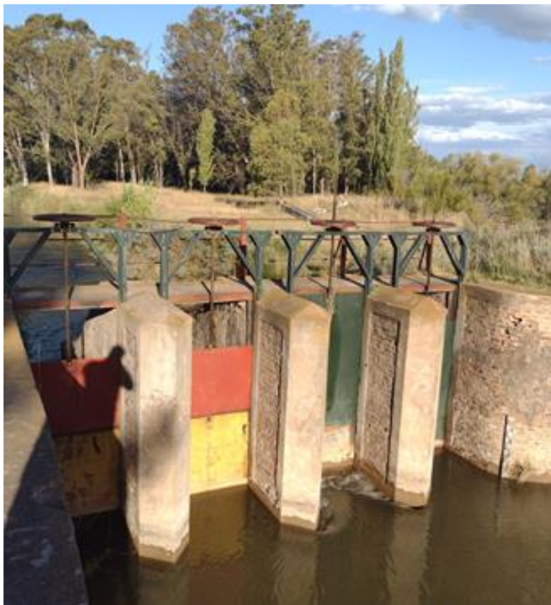
Figura 12. Vista de la toma del canal secundario "Santa Marina".
