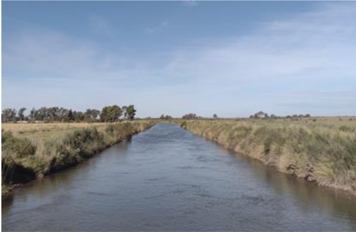
Figura 11. Vista del Canal primario "Unificador II".
