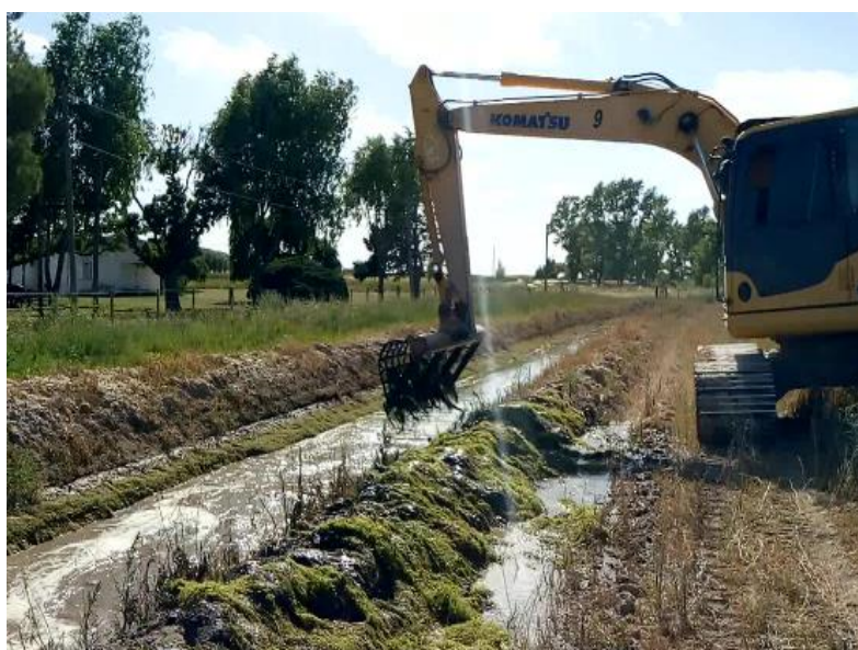
Figura 21: Control mecánico con retroexcavadora
