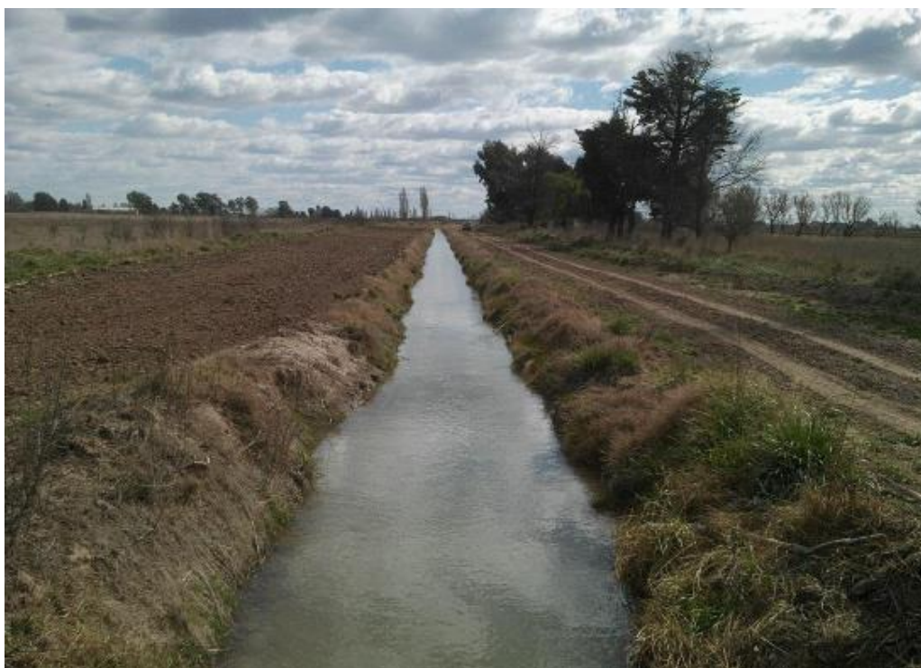
Figura 12: Mantenimiento y construcción de caminos de servicio
