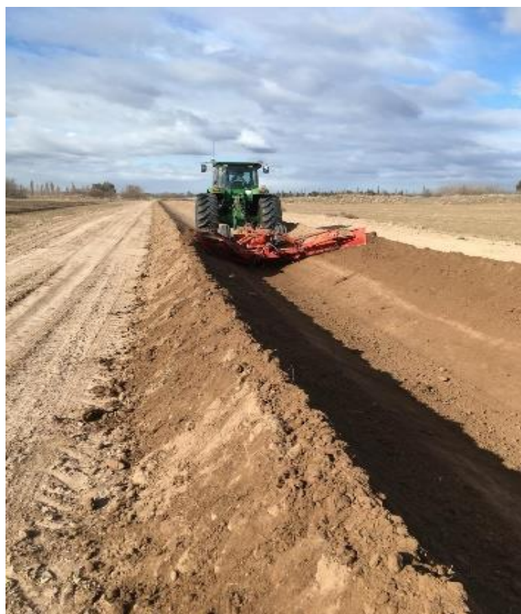
Figura 19: Ejecución de obras (apertura de un canal secundario)
