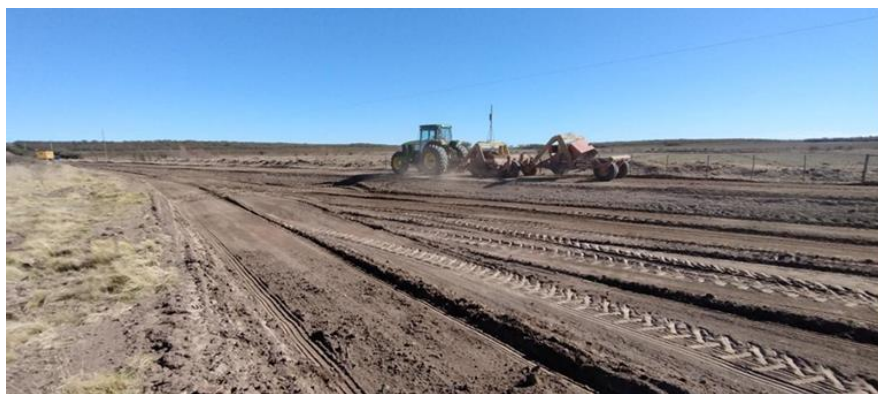
Figura 18 Rectificación de mesada
