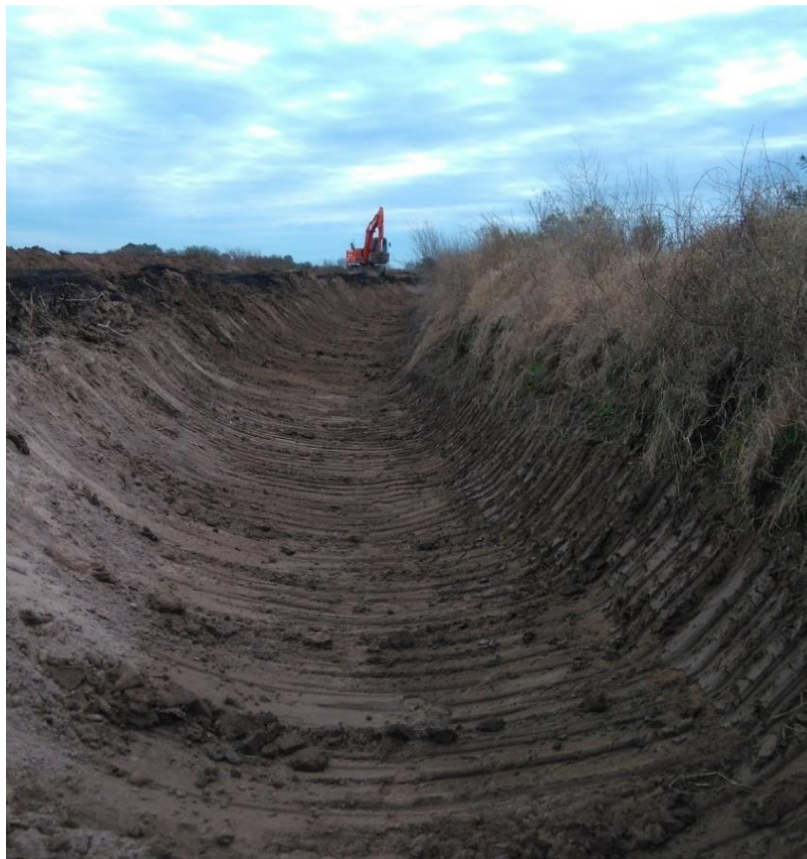
Figura 13: Limpieza de embanque dejando el canal con forma de U
