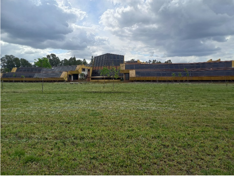
Figura 32 a y b. Vista general del sector 3
