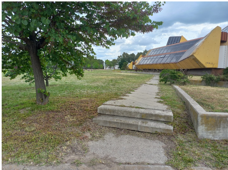
Figura 14. Vista de la vereda que rodea parte del edificio
