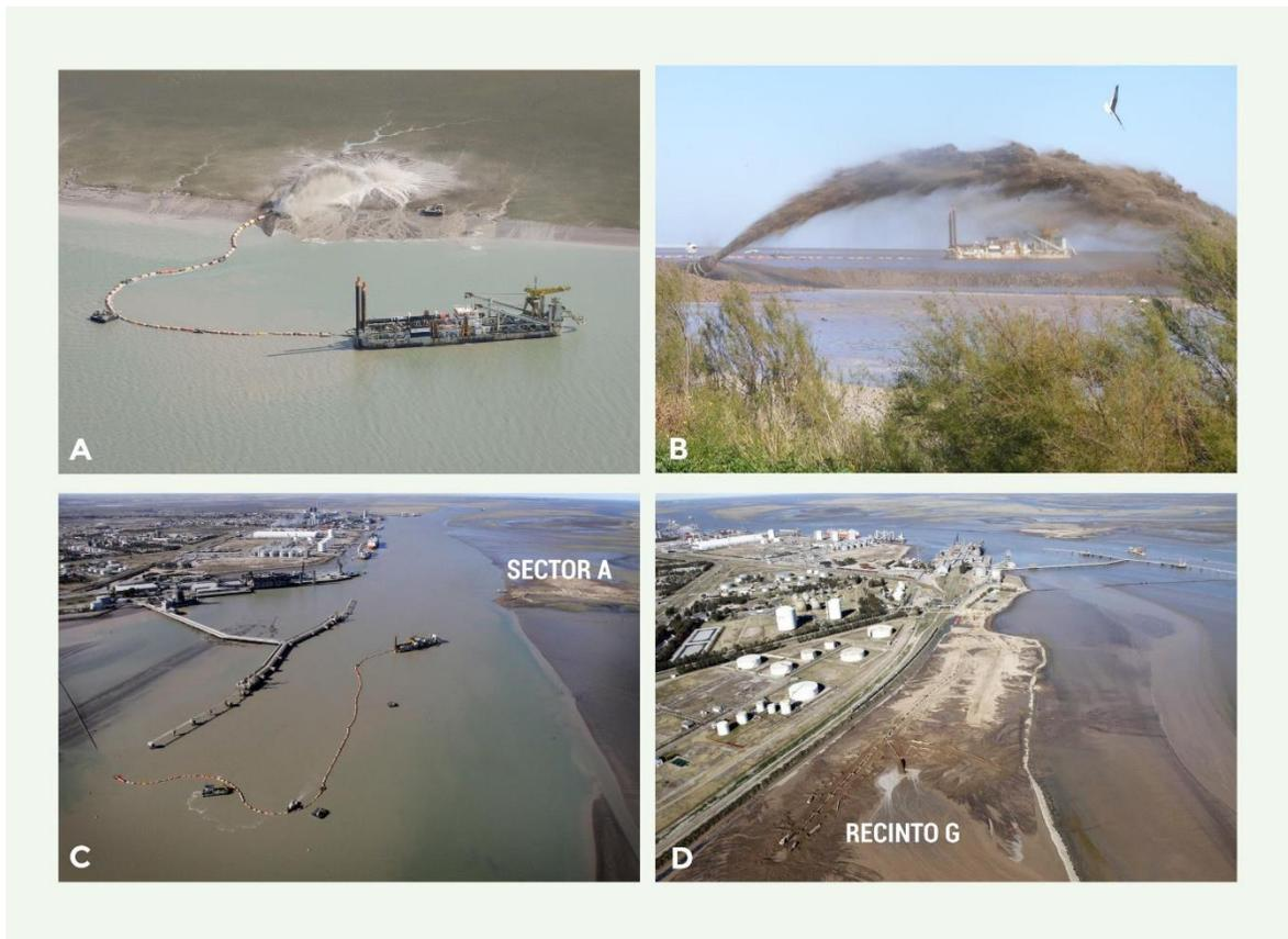
Figura 5.7. Dragado de profundización del canal interior y de las zonas de maniobras portuarias de los puertos de Ingeniero White y Galván (2013)
