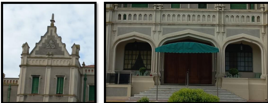
Figura 7: Detalles arquitectónicos del Hotel
