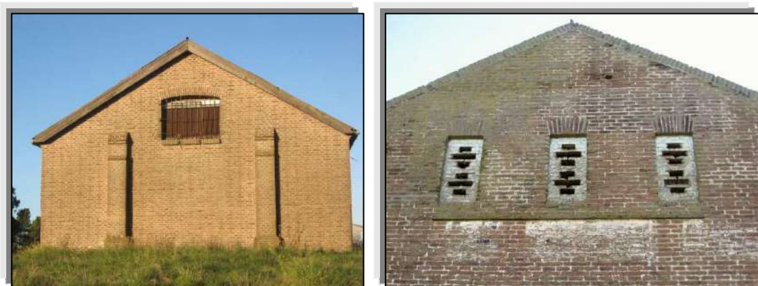
Figura 27 Depósito de ladrillo visto
