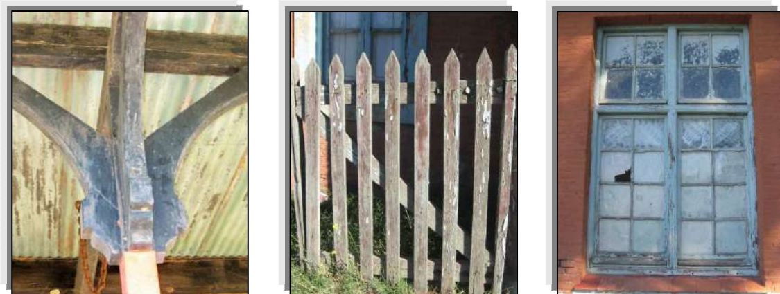
Figura 14 Carpinterías de madera
