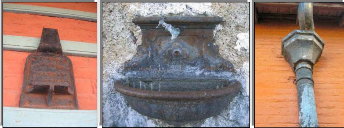
Figura 15 Trabajos en hierro
