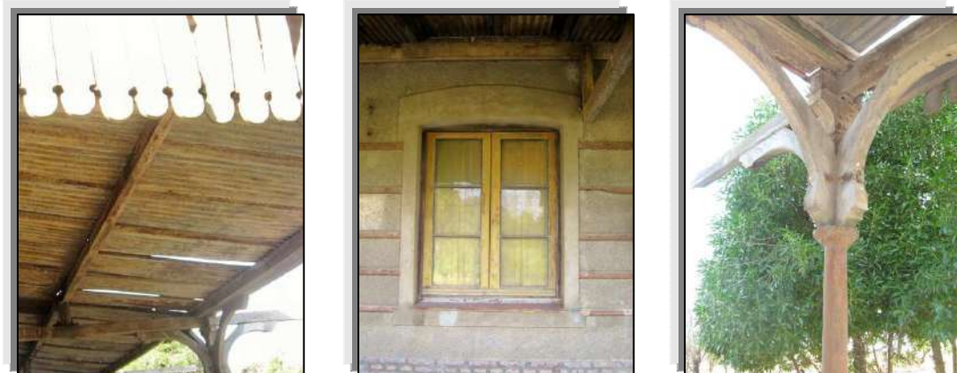
Figura 23 Carpinterías de madera y estructuras en hierro
