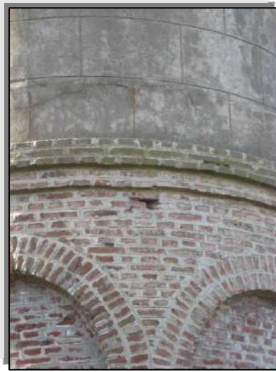
Figura 29 Tanque de ladrillo visto
