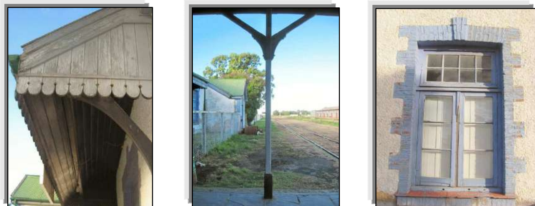
Figura 18 Carpinterías de madera
