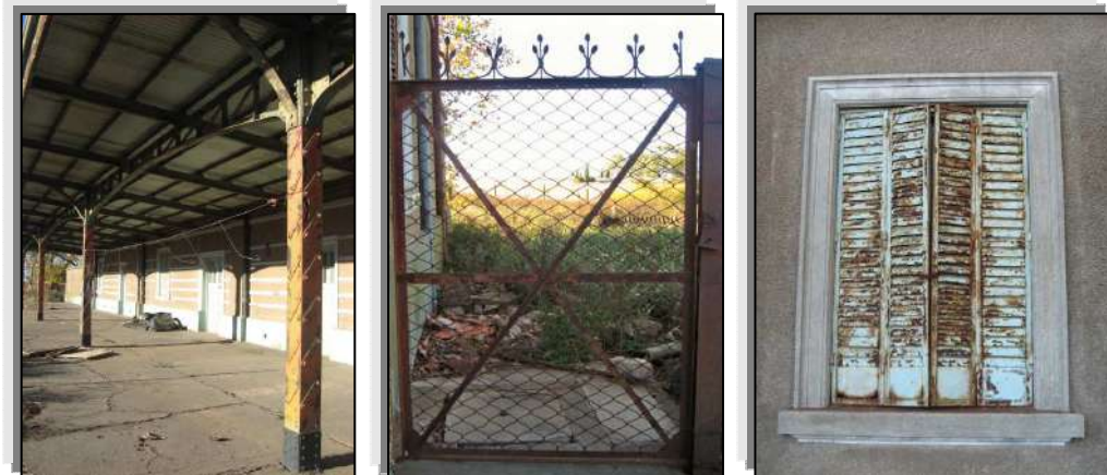
Figura 25 Estructuras y carpinterías en hierro
