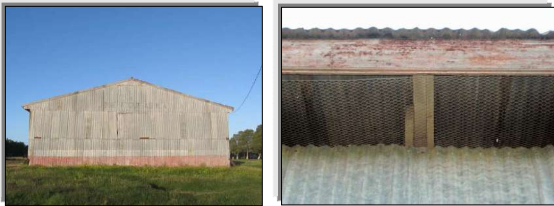
Figura 26 Depósito de chapa
