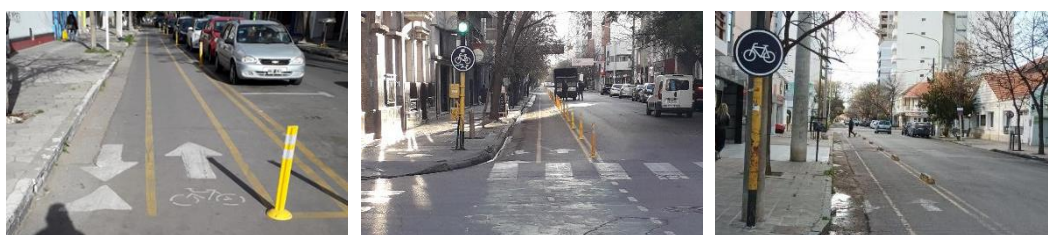
Figura 5.8. Ejemplos de ciclovías en la ciudad de Bahía Blanca, utilizando distintos tipos de barreras físicas para proteger a los ciclistas, vehículos estacionados (izquierda), bastones plásticos (centro) o topes de hormigón (derecha). Fuente: Propia.
