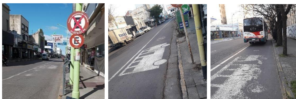
Figura 5.9. Delimitación de los carriles preferenciales para el transporte urbano de pasajeros con la correspondiente señalización e infografía, en microcentro de Bahía Blanca. Fuente: Propia.
