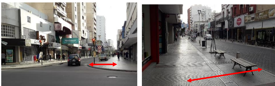
Figura 5.10. Semipeatonalización de la calle O'higgins (arriba) y Alsina (abajo). La flecha roja indica la ampliación de las aceras originalmente estrechas. Fuente: Propia.
