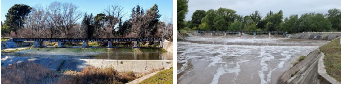
Figura 32. Dique derivador hacia el canal aliviador Maldonado en el Parque de Mayo. A la izquierda durante días secos y a la derecha luego de grandes precipitaciones en la cuenca media y alta.
