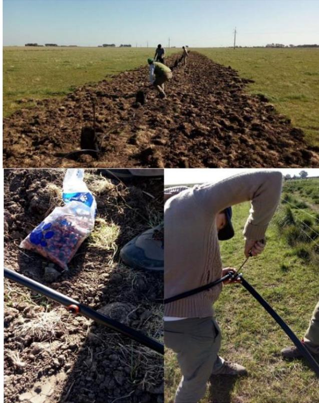
**Figura 15.** Distribución y acople de mangueras y disposición de goteros en el sitio 2.
