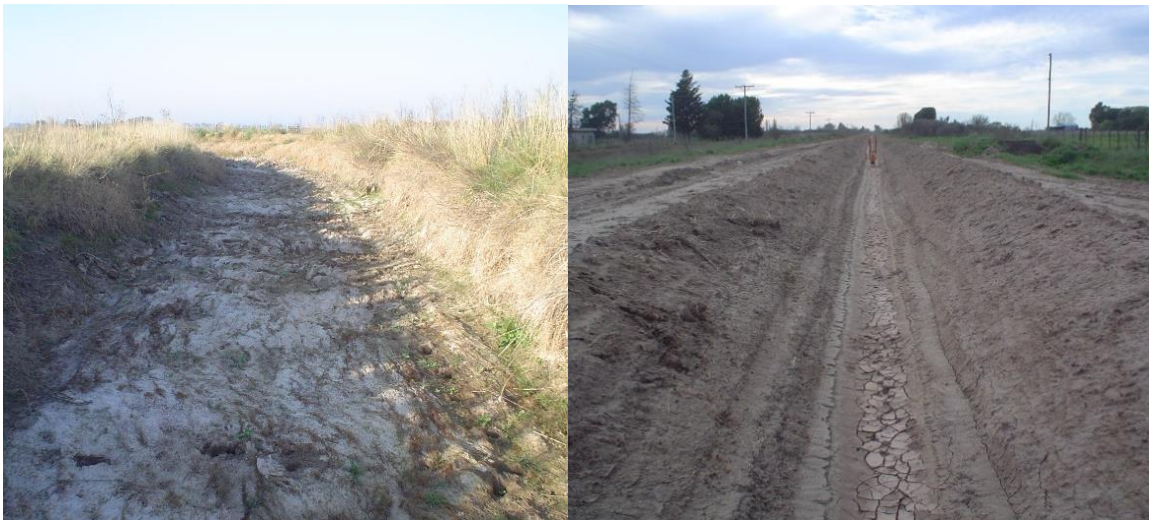
Figura 2.1. Canales de riego vacíos durante el receso invernal en el Valle Inferior del Río Colorado sin reestructurar (Izquierda) y canal reestructurado (Derecha).
