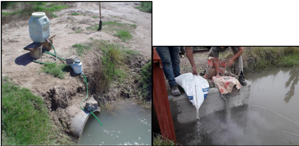
Figura 4.1. Metodología utilizada para la aplicación de compuestos en estado líquido (izquierda) y en estado sólido (derecha) en canales de riego con agua entre 2014 y 2019.
