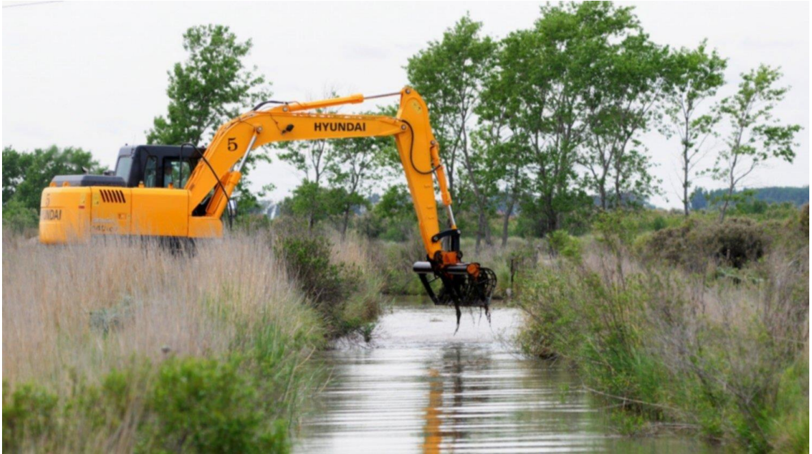
Figura 1.5. Limpieza de un canal de riego con retroexcavadora.
