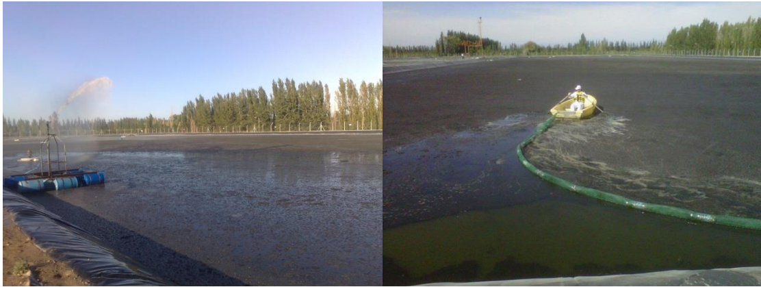
Figura 2.29: Levantamiento de sedimentos en la laguna facultativa.
