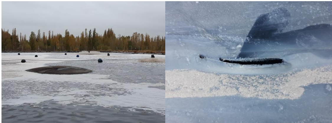
Figura 2.31: Levantamiento de la geomembrana por rotura debido a malas maniobras operativas.
