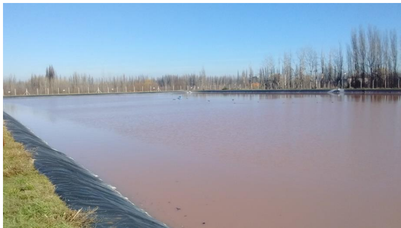
Figura 2.30: Enrojecimiento de la laguna de tratamiento por aparición de Thiopedia rosea .
