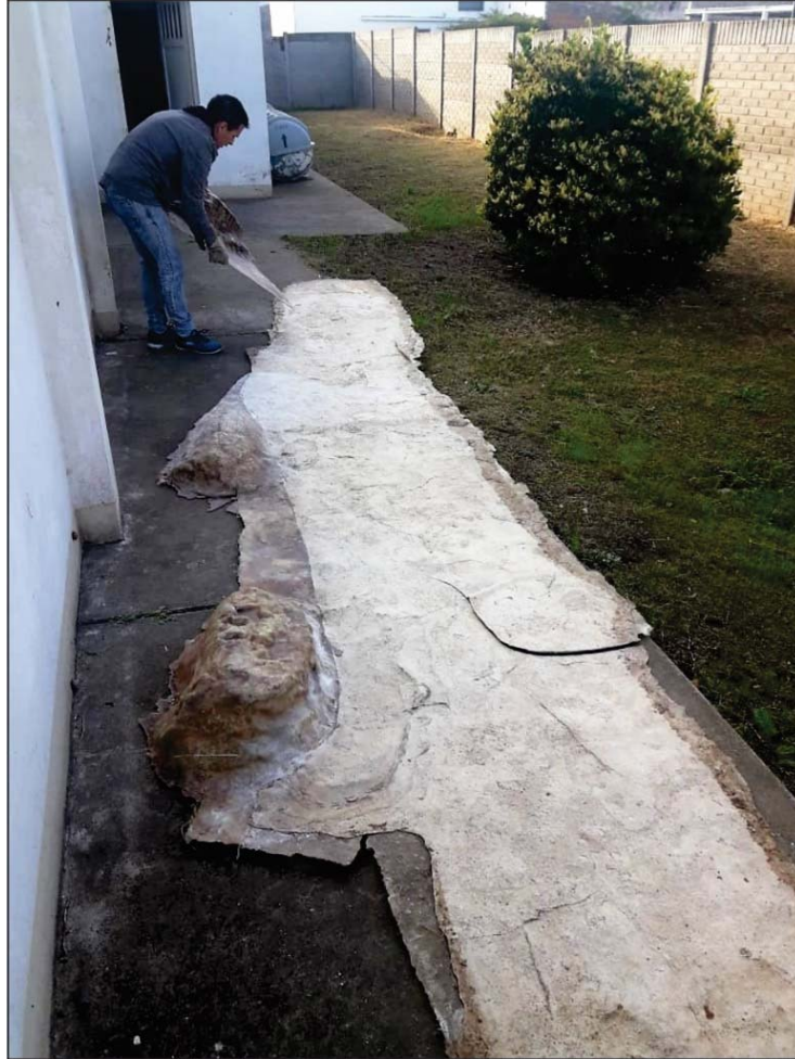
Figura 2.13. Montaje de moldes de caucho siliconado en el MD.
