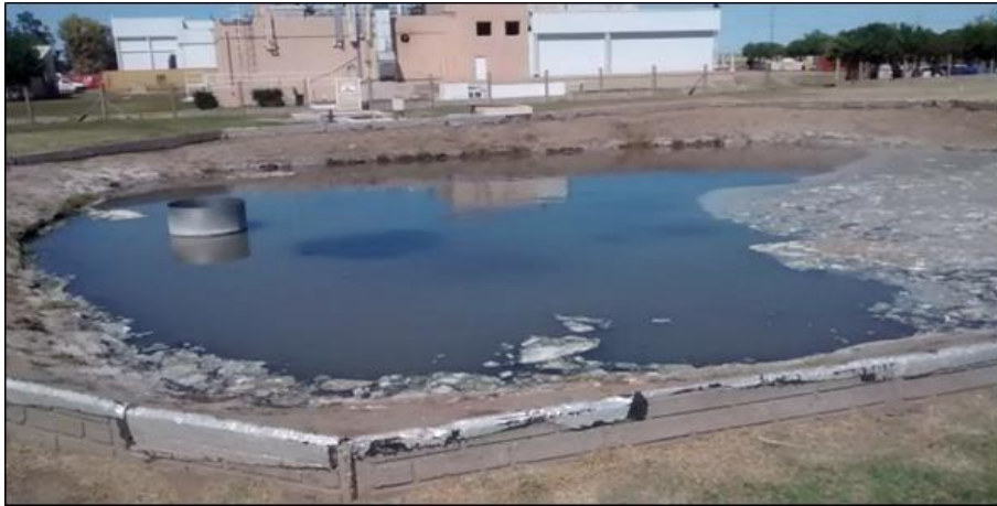
Figura n° 10. Laguna n° 1: tratamiento anaeróbico.
