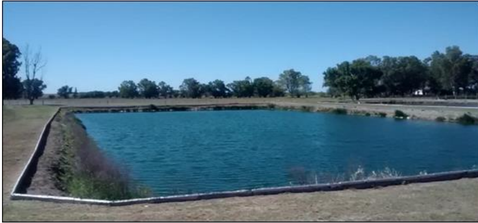
Figura n° 12. Laguna n° 3 aeróbica y receptora.
