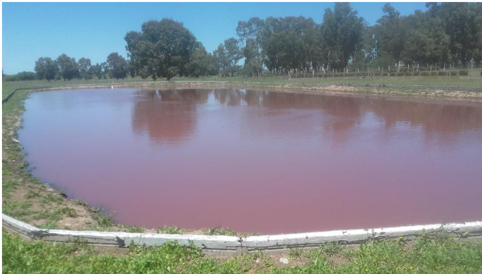
Figura n° 11. Laguna n° 2 facultativa.
