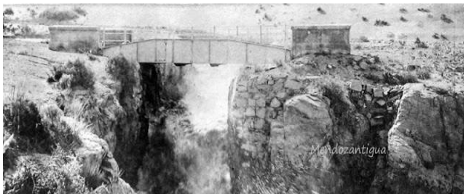
Figura 56: Puente en la zona de los saltos del Nihuil. Fuente: www.mendozaantigua.blogspot.com
