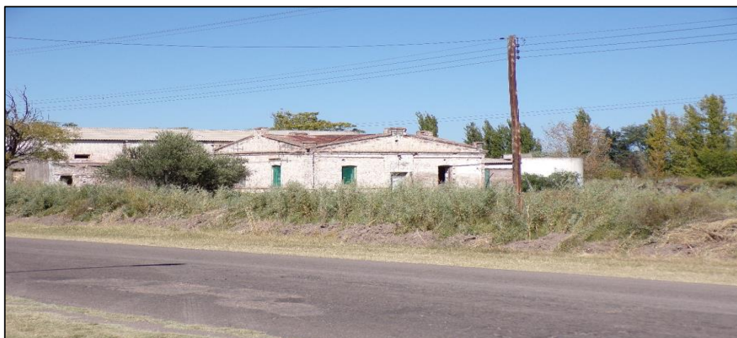
Figura 116: instalaciones abandonadas, zona de Gral. Alvear. Fuente: Langhoff (2018).
