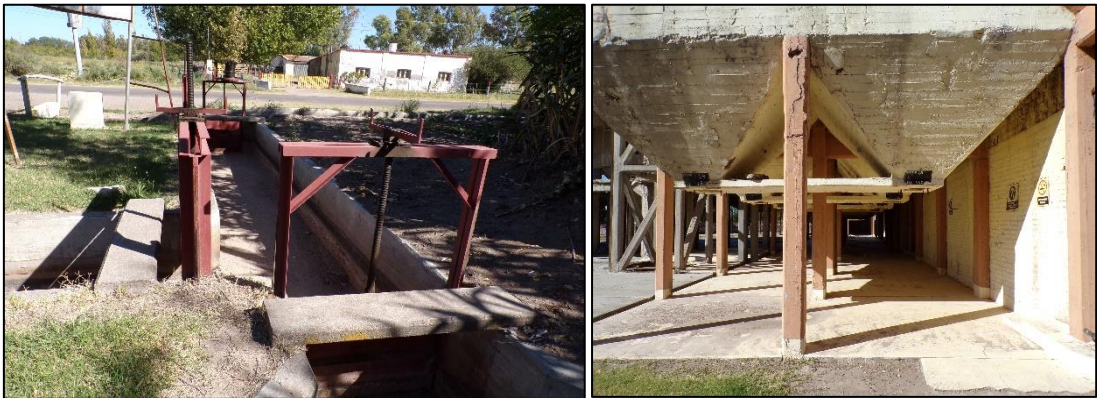
Figura 45: Bodega Faraón a) acequia; b) cubas (Gral. Alvear). Fuente: Langhoff (2019 y 2018).
