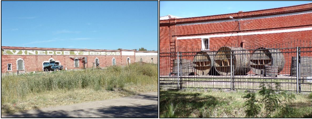
Figura 113: empresa Villa Atuel S.A. a) y b) adaptación instalaciones ex-bodega Arizu.
