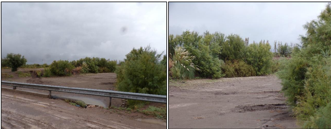
Figura 22: Río Atuel cuenca inferior a) zona puente viejo Algarrobo del Águila; b) cauce seco. Fuente: Langhoff (2011; 2018; 2019).
