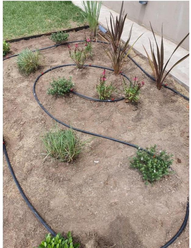
Figuras 8: Etapa de plantación y colocación del riego por goteo automatizado.
