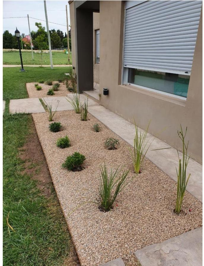
Figura 10: Etapa de finalización de la obra, colocación de tela geotextil y piedras decorativas.
