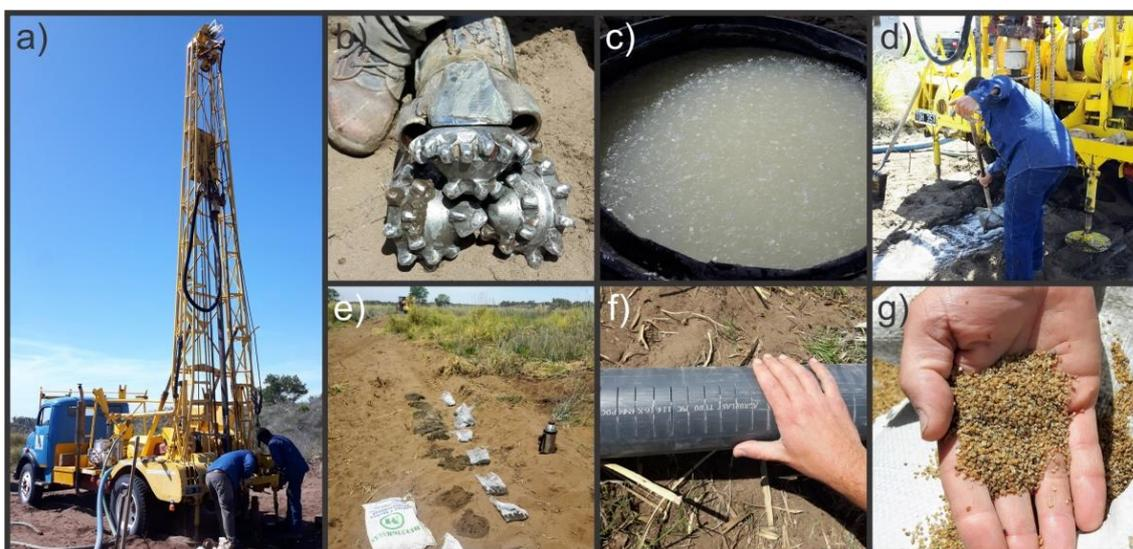
Figura 2.5.5.1: Operaciones de perforación, a) equipo de perforación; b) trépano tricono; c) lodo espesado con gelificantes; d) toma de muestras litológicas; e) muestras de sedimentos de la perforación; f) filtro de PVC ranurado; g) grava tipo Paraná.
