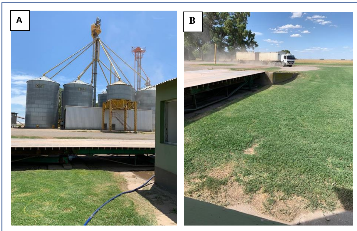
Figura 4. Fotografía de (A) la planta de silos e (B) ingreso de un camión a la balanza.
