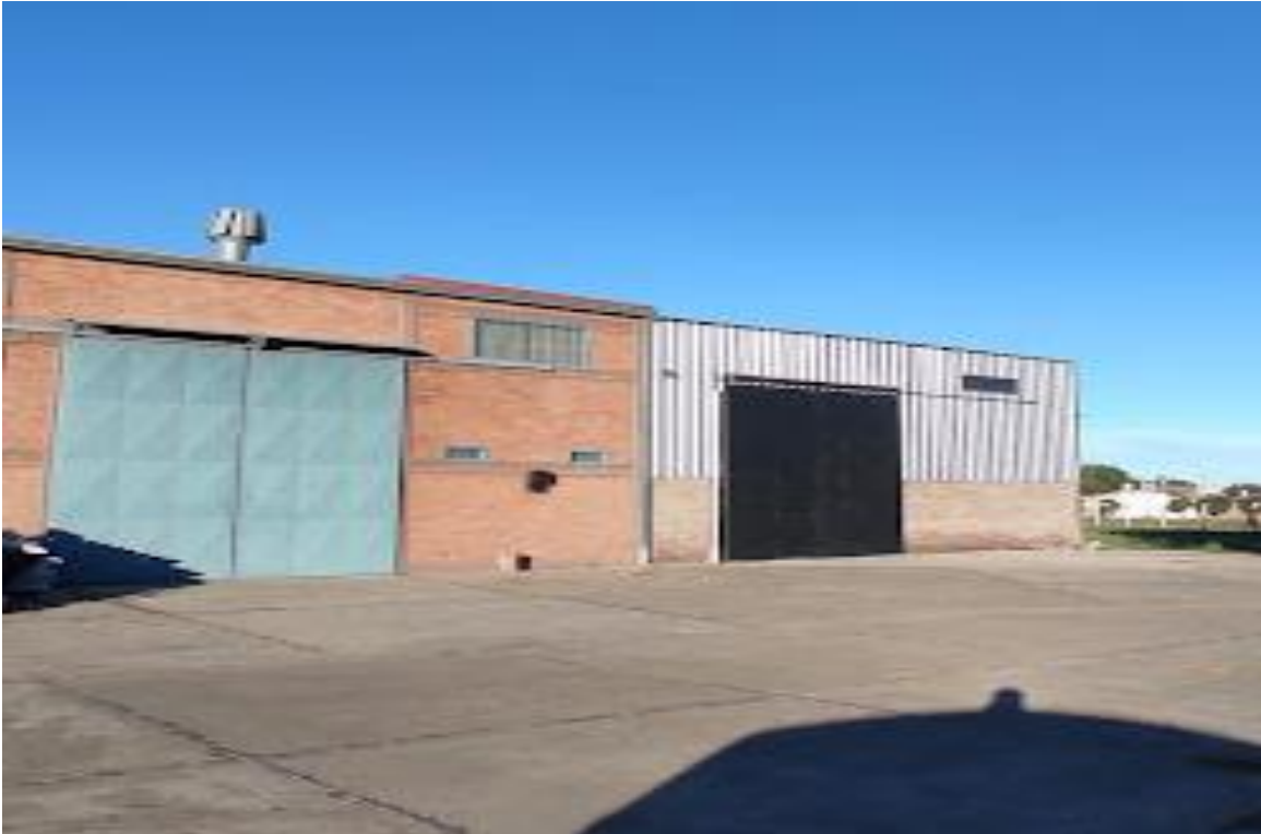
Foto N°2: vista general del nuevo galpón.
