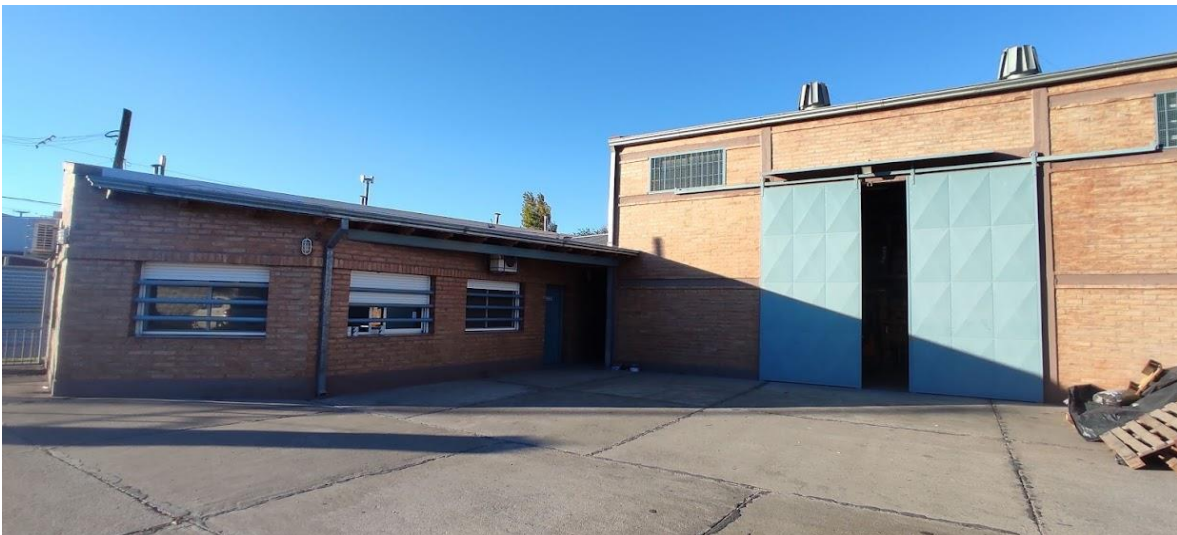
Foto N°1: Vista general de la oficina y del primer galpón de insumos.
